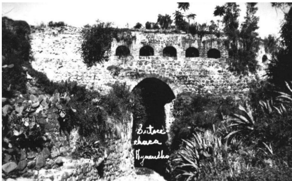
Figura 46 Puente y acueducto Sutuq Chaka
