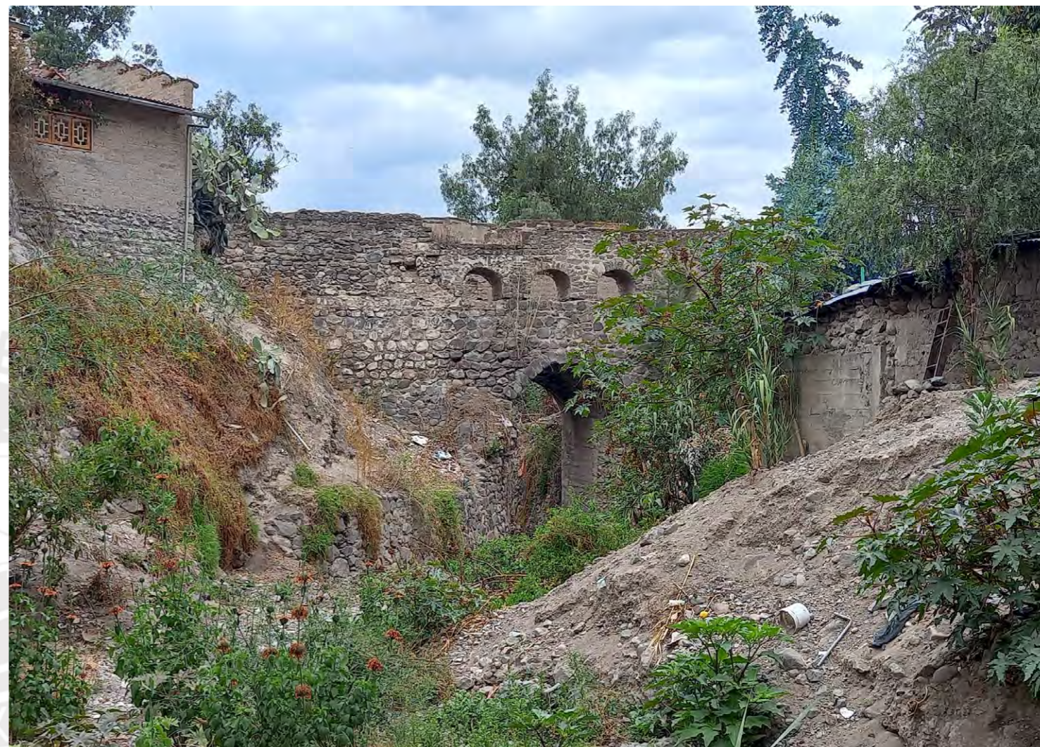
Figura 47 Estado actual del puente y acueducto Sutuq Chaka
