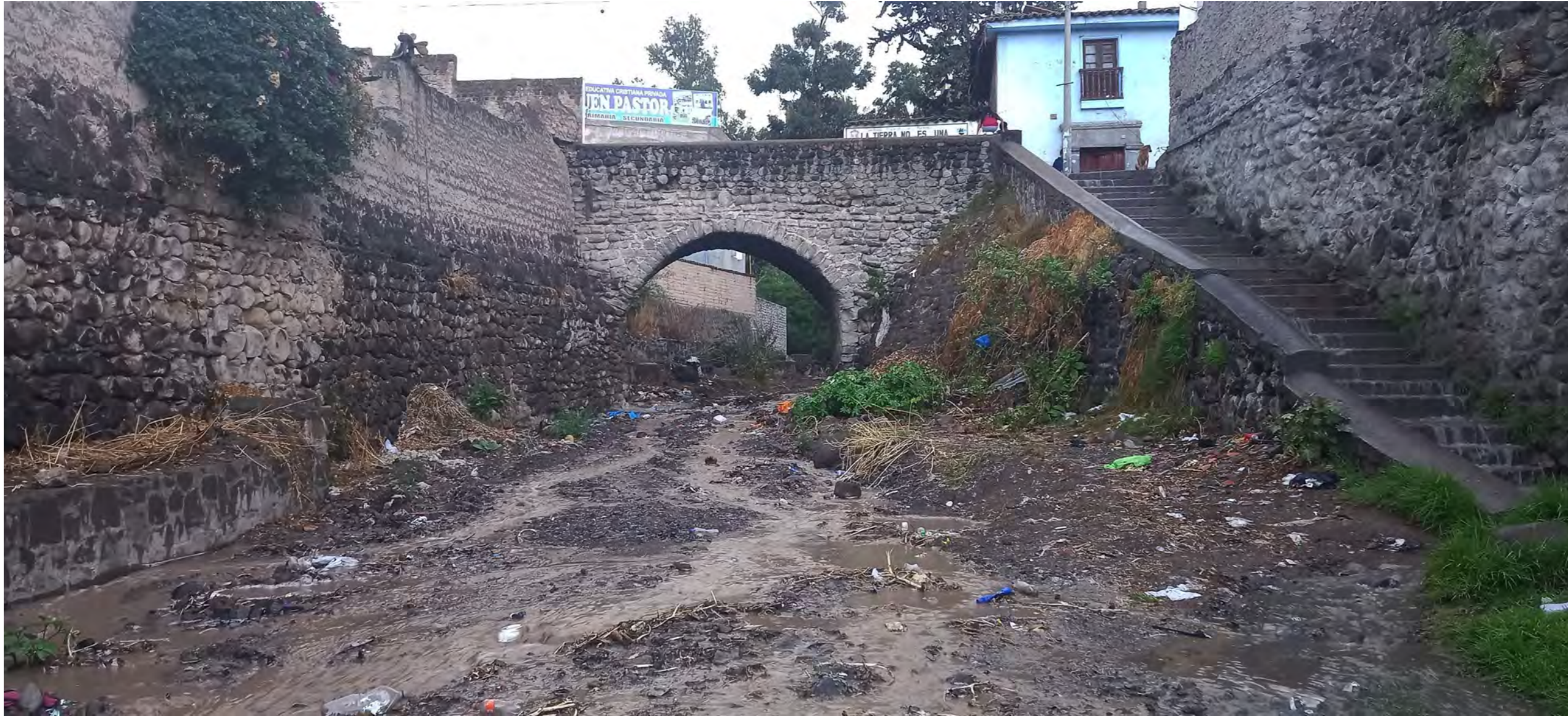
Figura 50 Escorrentía del arroyo y del puente colonial, por inundación del jr. Miguel Grau
