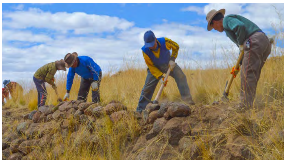
Figura 3 Rehabilitación de Andenes, SUMA MARKA ONGD
