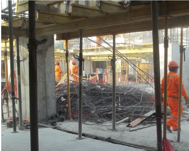
Figura 3.21: Acopio temporal de desechos de acero en la obra. Fuente propia.
