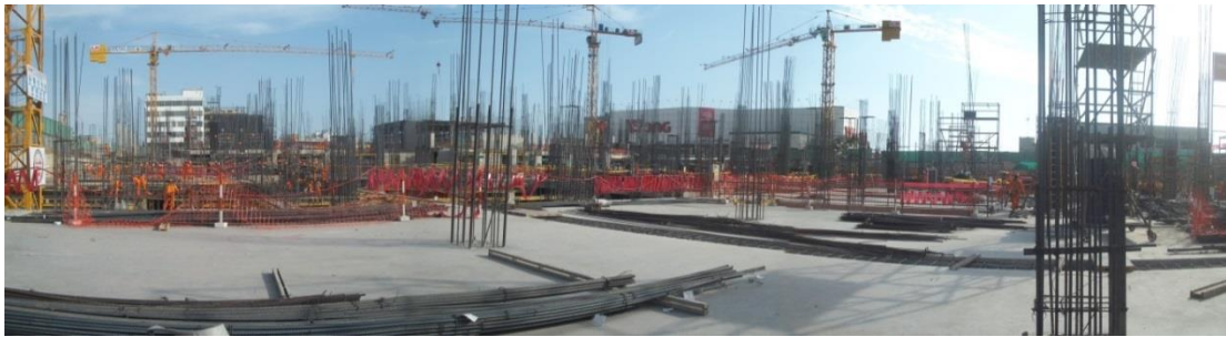
Figura 3.13: Vista panorámica del proyecto. Fuente propia
