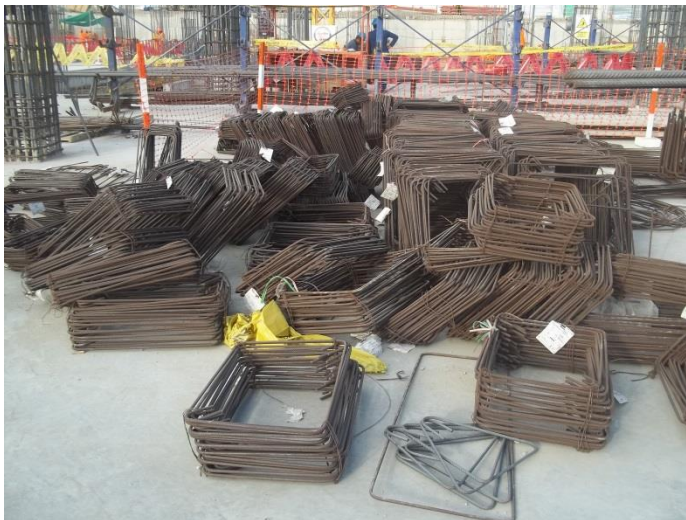
Figura 3.22: Estribos de acero prefabricado. Fuente propia
