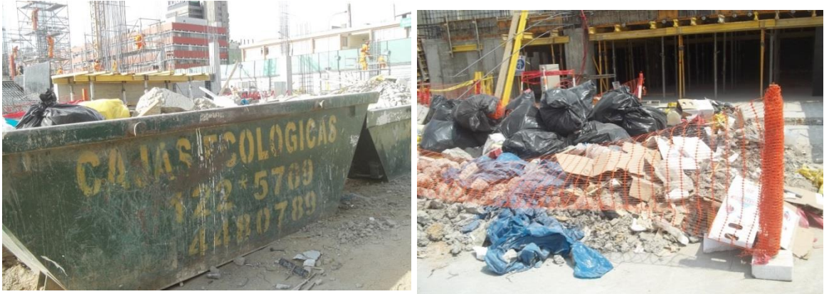
Figuras 3.18 y 3.19: 3.17 (izquierda) Caja Ecológica de la obra. 3.18 (derecha) acopio temporal de residuos de la obra. Fuente propia
