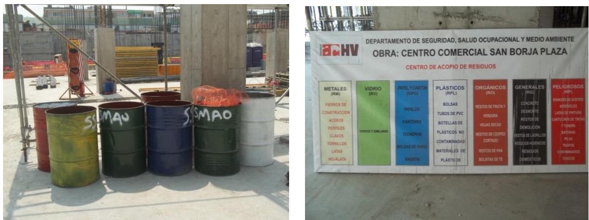
Figuras 3.16 y 3.17: Izquierda - Cilindros metálicos en la obra. Derecha - Cuadro informativo de la distribución de cilindros metálicos por colores. Fuente propia
