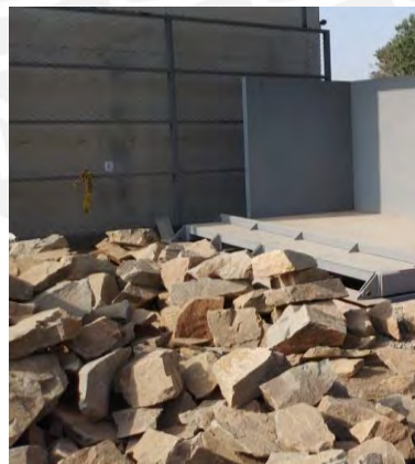
Figura N°5. 3 Mesa inclinable y material para el muro (piedra) [Fotografía: Ramos / Terbullino, 2020]
