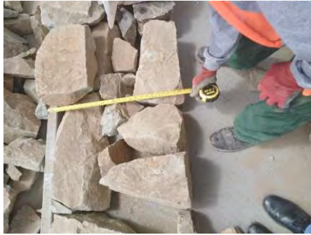
Figura N°5. 8 (a) Verificación del ancho del muro [Fotografías: Ramos / Párraga, 2020]
