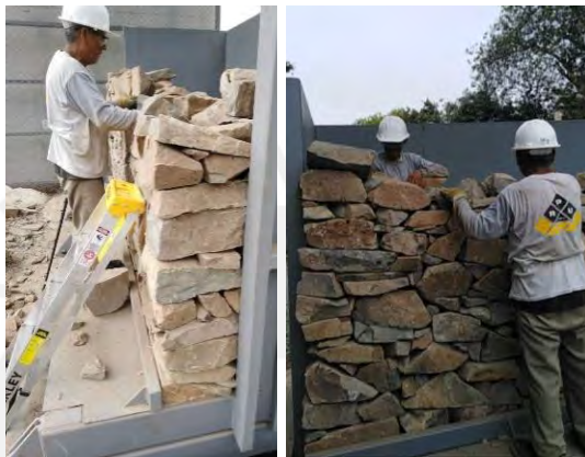
Figura N°5. 14 Avance intermedio en la construcción del muro II [Fotografías: Ramos / Párraga, 2020]
