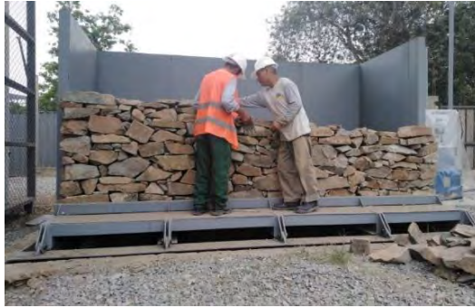
Figura N°5. 13 Avance intermedio en la construcción del muro I [Fotografías: Ramos / Párraga, 2020]
