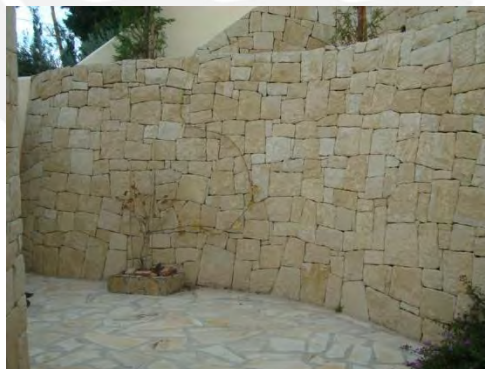
Figura N°3. 4 Muro de contención de Piedra II ([Fotografía: construccionesrnc, por construccionesrnc, https://construccionesrnc.com/muro-de-contencion-de-piedra-en-seco/ ]
