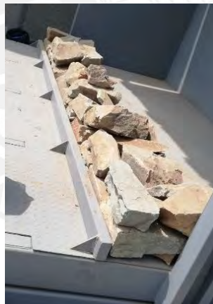
Figura N°5. 12 Detalles del muro [Fotografías: Ramos / Párraga, 2020]
