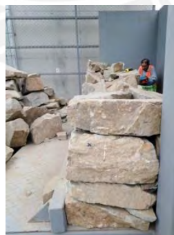
Figura N°5. 10 (a) Vista lateral del muro [Fotografías: Ramos / Párraga, 2020]
