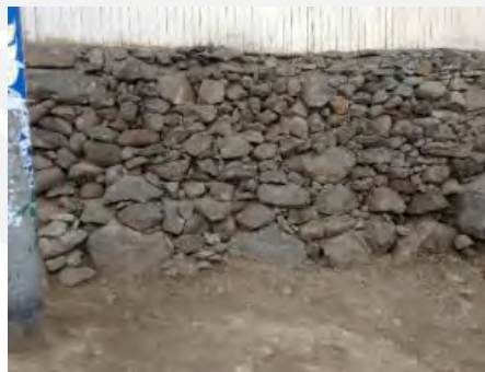
Figura N°2. 4 Pirca elaborada en Perú usando bloques de dimensiones variadas [Fotografía: Quispe, 2019]
