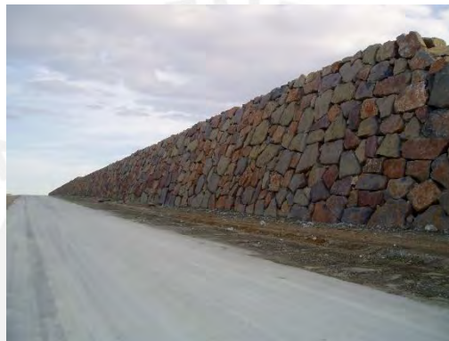
Figura N°3. 3 Muro de contención de Piedra [Fotografía: Sumelzo, por Sumelzo, 2005, https://sumelzo.com/obra-73-muro-de-contencion-colocado-en-poligono-ptr ]
