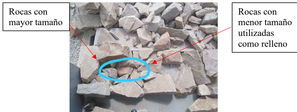
Figura N°5. 11 (a) Construcción del muro [Fotografías: Ramos / Párraga, 2020]
