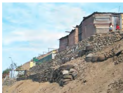
Figura N°1. 2 Muros tipo pirca como sistema de contención [2]
