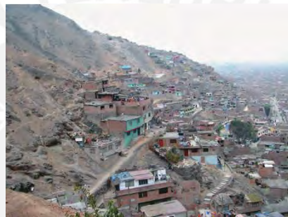
Figura N°1. 1 Laderas del Cerro El Agustino [Fotografía: J. Robert,2017] [2]
