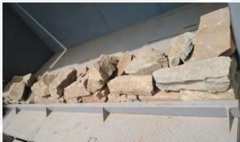
Figura N°5. 9 (a) Base del muro [Fotografías: Ramos / Párraga, 2020]
