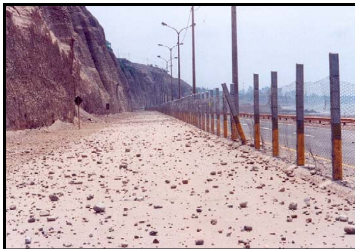
Foto 6.04 Distribución de cantos caídos a través del tramo.
