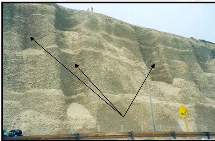
Foto 6.01 Formaciones en el talud a manera de cilindros, causados principalmente por la erosión eólica.
