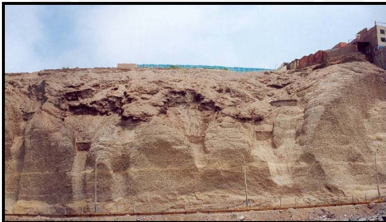
Foto 6.07 Estado actual del relleno ubicado entre P 0+030 y P 0+150 (2003)
