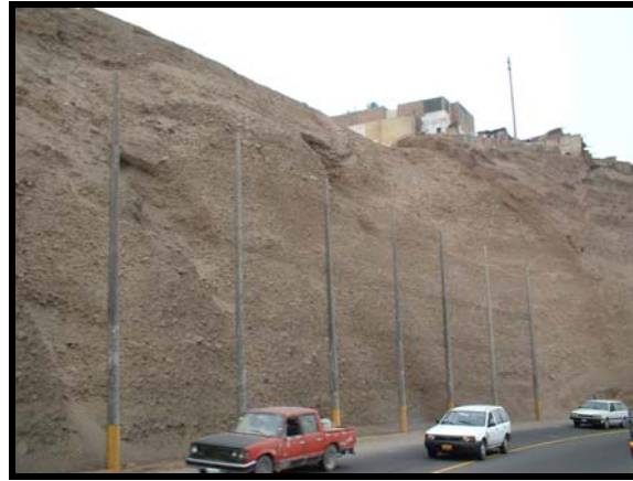
Foto 7.07 Colocación de postes en la Costa Verde.
