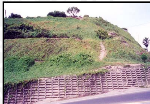
Foto 7.06 Cribwalls de San Isidro.
