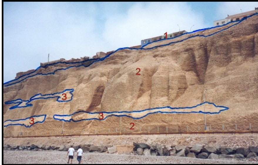
Foto 4.06 Vista panorámica de progresivas P + 250 a P + 500.
