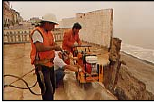
Foto 7.01 Remoción de muros y pavimento de la corona para evitar accidentes progresiva 0+400. 10 de Marzo del 2002. Defensa Civil.
