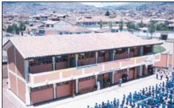
Figura 2.8 Edificio 780 pre NDSR-1997 de 3 aulas por piso en la sierra peruana
