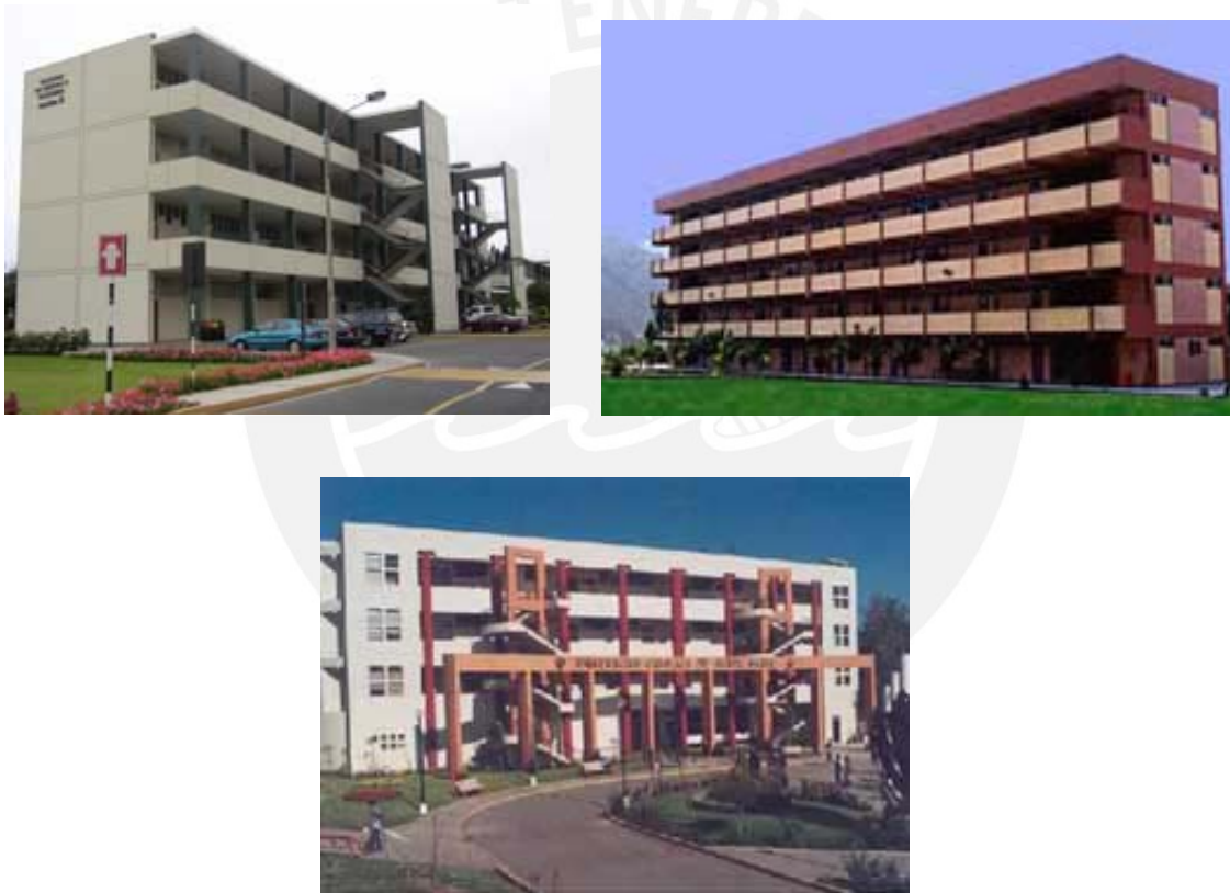
Figura 2.24 Edificio de educación superior pre NDSR-1997
