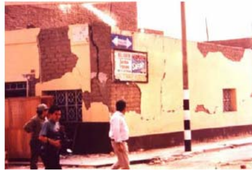
Figura 2.20 Falla por flexión en las esquinas (Izq.) Vivienda con fallas de flexión (Der.) (Fuente: A. San Bartolomé)
