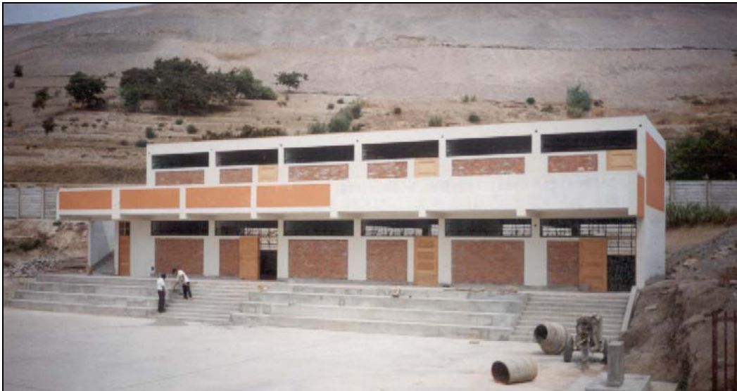
Figura 2.7 Edificio 780 pre NDSR-1997 de 3 aulas por piso en la costa peruana
