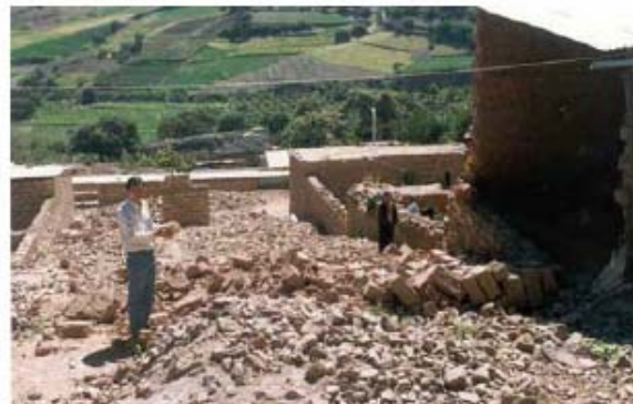
Figura 2.22 Falla por volteo (Izq.) Colapso de un muro por volteo (Der.) (Fuente: D. Quiun)
