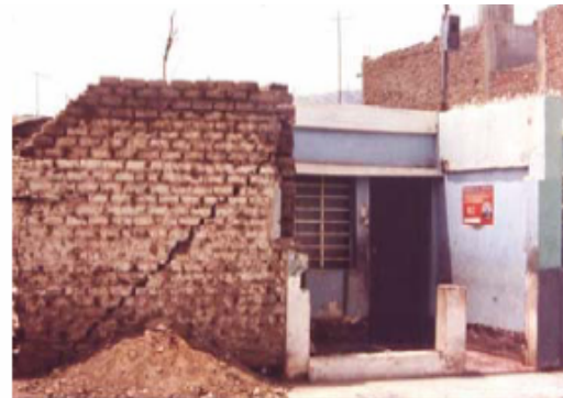
Figura 2.21 Falla por corte (Izq.) Daño registrado en una vivienda (Der.) (Fuente: D. Quiun)
