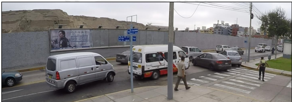
Figura 85: Intersección Av. Dintilhac y La Mar
