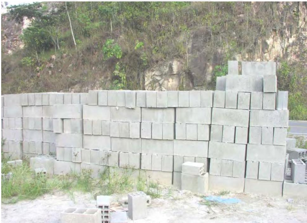
Figura N° 9. Fabricación de ladrillos silico-calcáreos (Fuente: A. Díaz) [Díaz, 2009]
