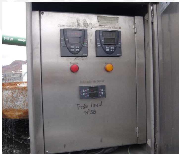
Fig. 4.14. Controlador local de nivel de la interface pulpa / cama de espumas.
