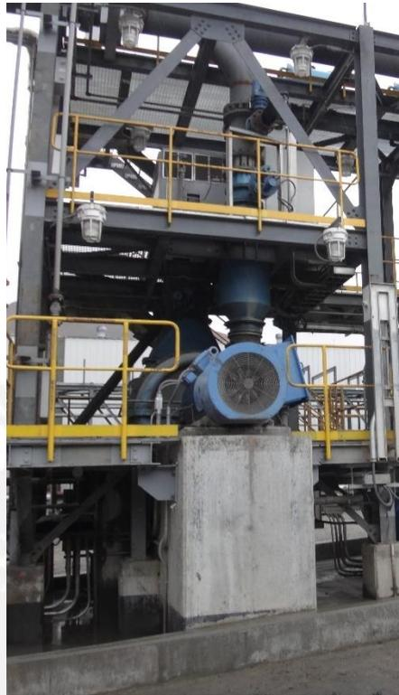
Fig. 4.15. Soplador de aire de la celda columna.
