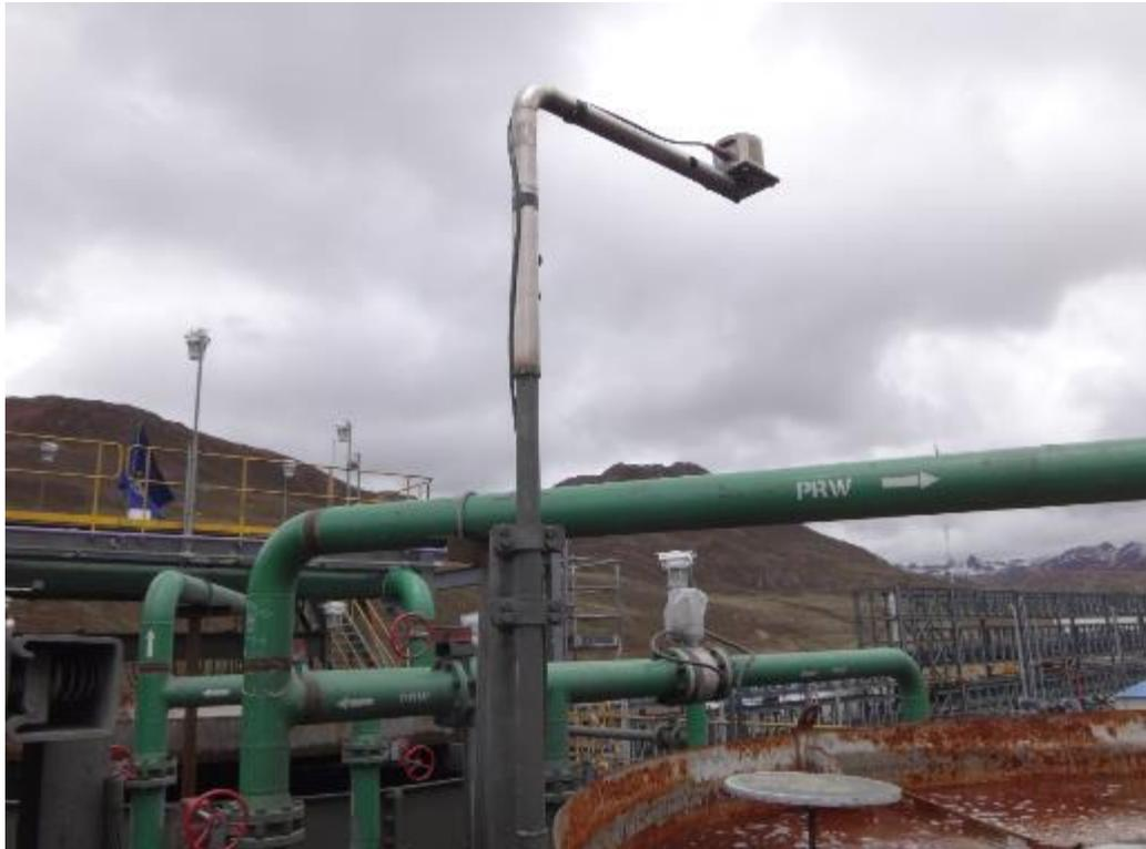
Fig. 4.13. Sensor de nivel de la interface pulpa / cama de espumas.
