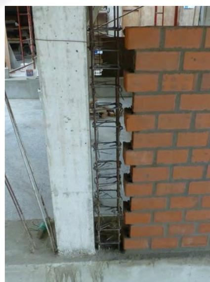
Fotos 5 y 6. Detalle de la secuencia de construcción de “Tabiques de albañilería”, con arriostres de borde
