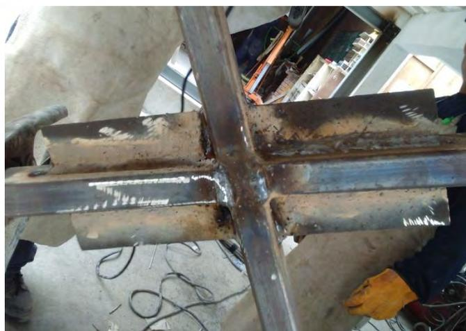
Fotos 9, 10, 11 y 12. Elementos metálicos usados en la preparación de Marcos de Acero con Arriostres concéntricos, para implementar el “Sistema de Reforzamiento” del Módulo reforzado
