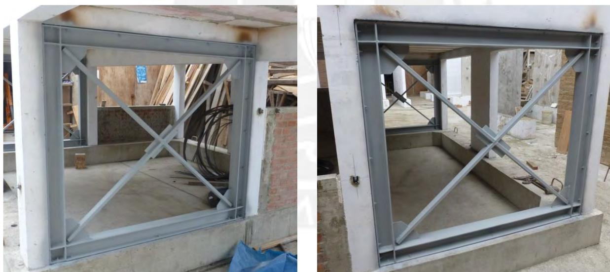
Fotos 37 y 38. Reforzamiento con marco metálico, adherido al Módulo reforzado, en condición final, previo al ensayo de simulación sísmica.
