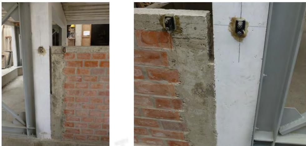
Fotos 39 y 40. Detalles de “juntas rebajadas” entre columnas y tabiques de albañilería.
