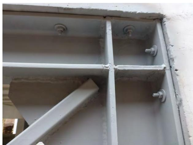
Fotos 30 y 31. Uniones soldadas, terminadas y protegidas con base anti-corrosiva, sujetas al Módulo reforzado, en la parte superior.
