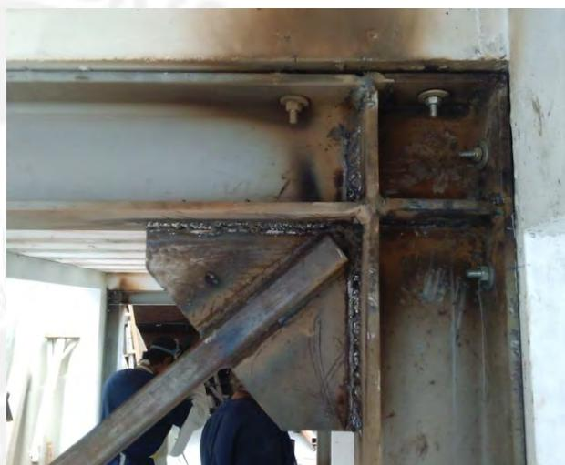
Fotos 26, 27, 28 y 29. Detalle de las uniones soldadas y de ubicación de los pernos de anclaje del marco metálico en columnas y vigas del Módulo reforzado
