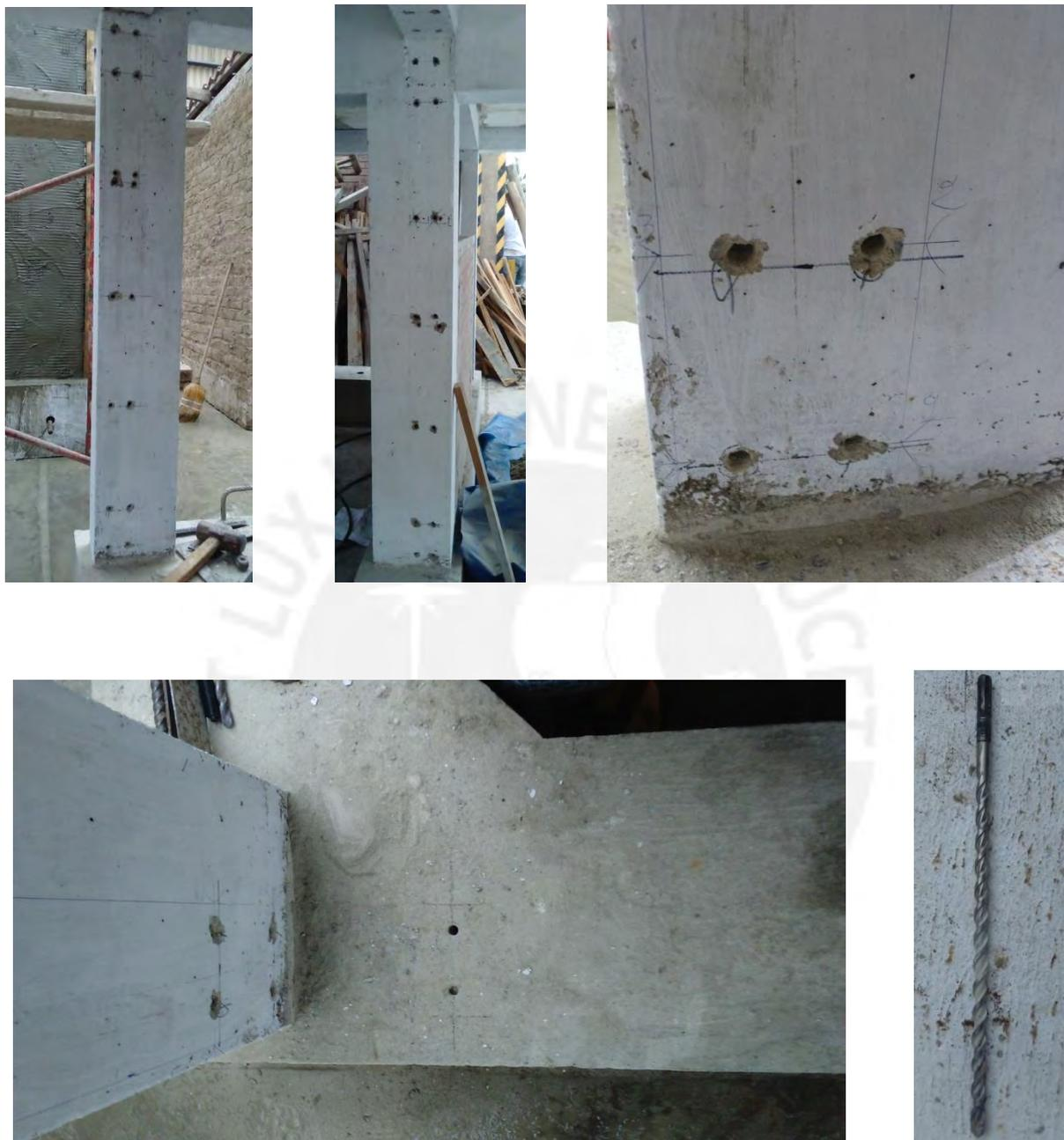
Fotos 18, 19, 20, 21 y 22. Ubicación los orificios realizados en la cara interior de las columnas y vigas, para sujetar el marco metálico de reforzamiento. Broca de perforación de 8mm.
