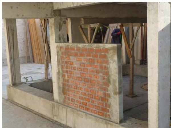
Fotos 7 y 8. Detalle de la secuencia de construcción de “Tabiques de albañilería”, con arriostres de borde de concreto armado, tanto en el primer piso, como en el segundo piso, con juntas de separación
