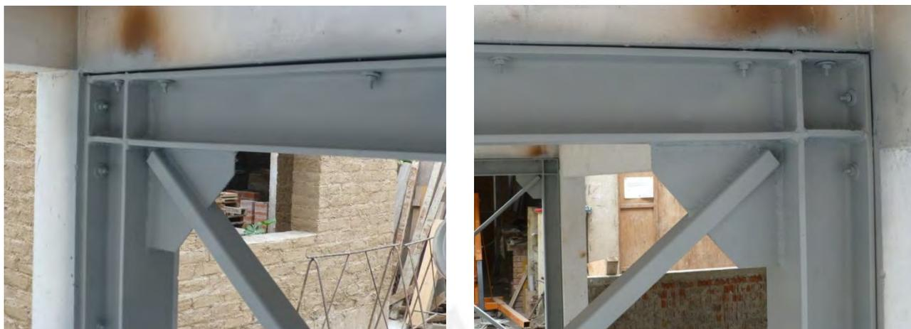
Fotos 35 y 36. Junta (huelgo) apreciable entre superficie exterior de las alas del perfil metálico y la superficie de concreto, debido a imperfecciones de “planitud” en caras interiores de vigas y columnas de concreto. Este hecho, requiere atención.
