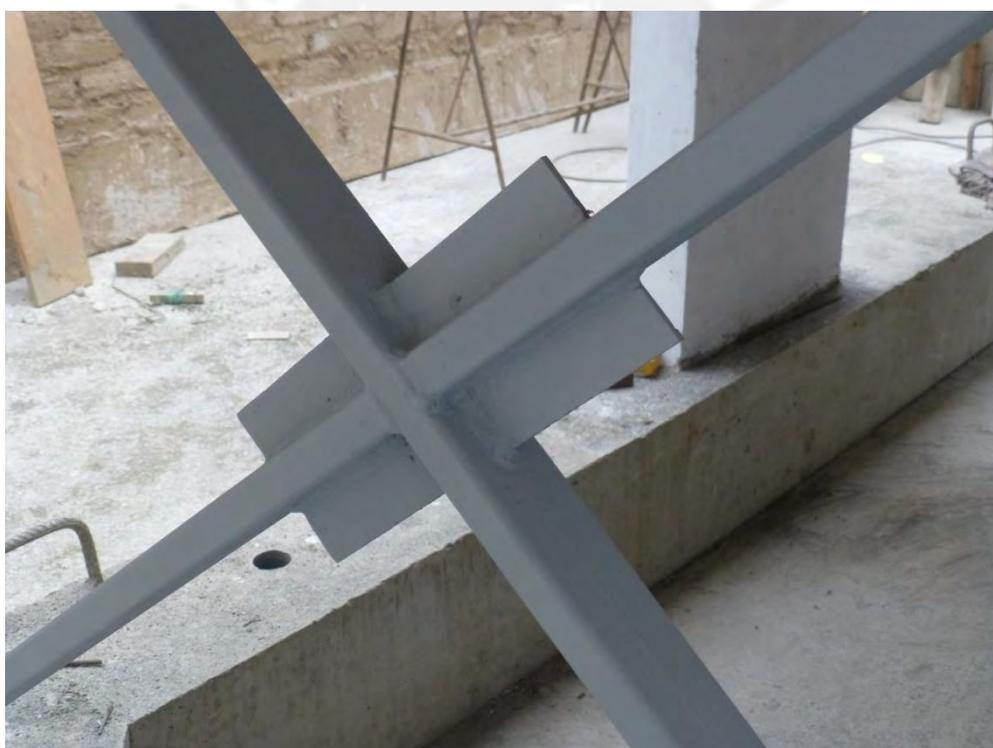
Fotos 32, 33 y 34. Uniones soldadas, terminadas y protegidas con base anti-corrosiva, sujetas al Módulo reforzado, en la base del pórtico. Además, detalle de la unión cartelada entre arriostres diagonales.
