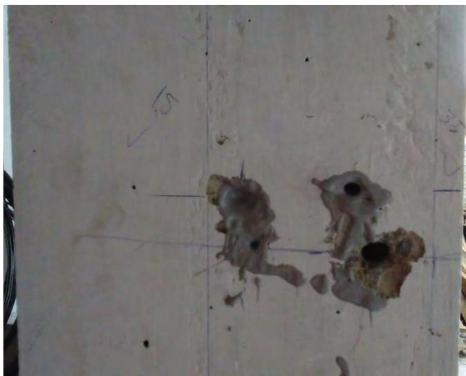
Fotos 23. Al perforar las columnas, se presentaron dificultades, debido a la ubicación del refuerzo de la columna, razón por la que se tuvo que re-perforar. Sellado de orificios con material epóxico, para sujetar el marco metálico mediante pernos de anclaje.
