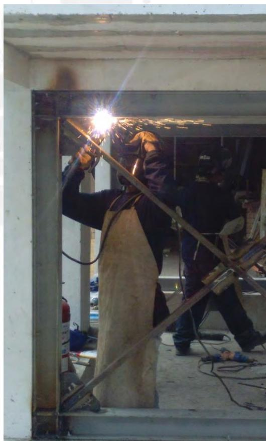
Fotos 24 y 25. Proceso de sujeción y de soldado del marco metálico de reforzamiento del Módulo reforzado.
