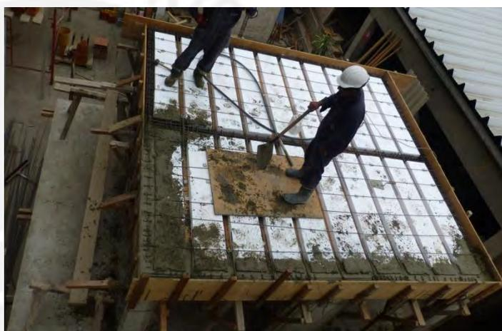
Fotos 1, 2, 3 y 4. Proceso constructivo del Módulo reforzado. Encofrado de Vigas, Columnas y hormigonado de primer y segundo techos
