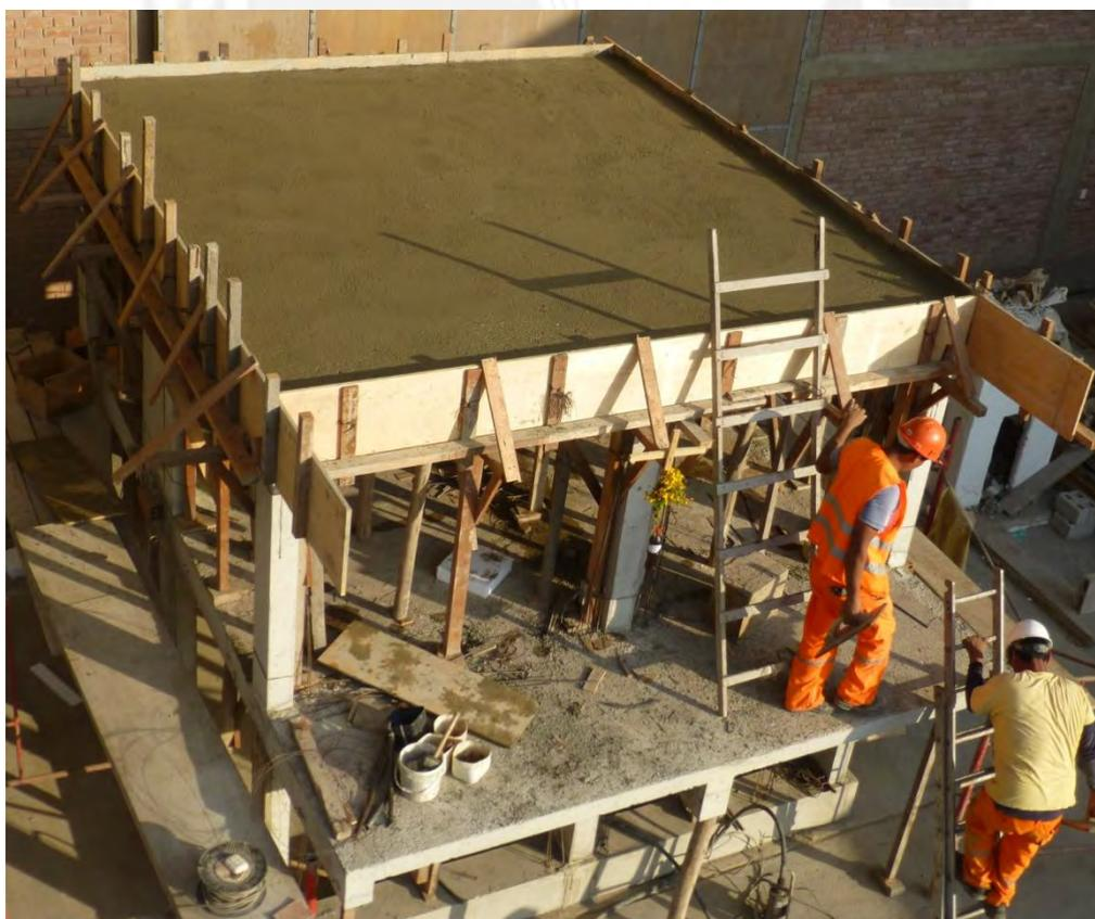
Fotos 9 y 10. Encofrado de Vigas y hormigonado del segundo techo
