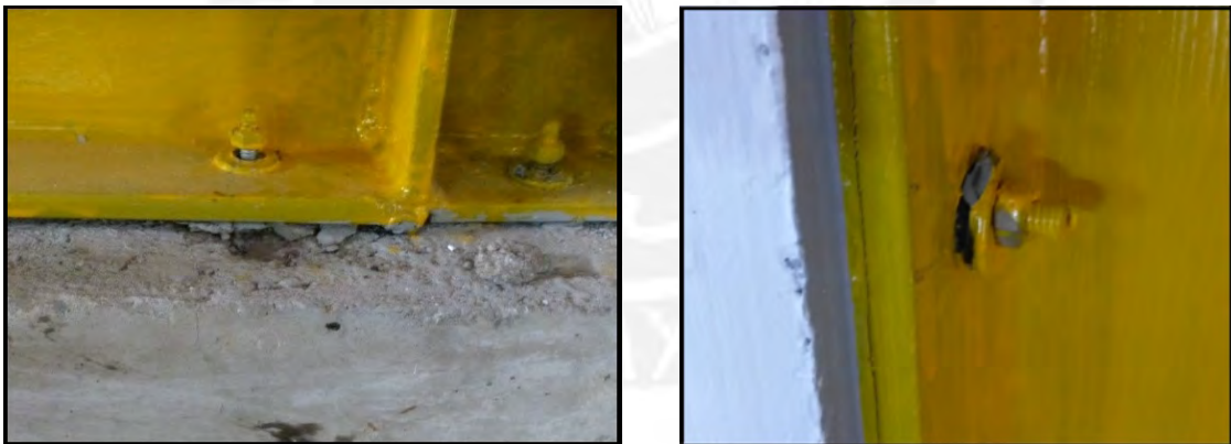
(a) Pernos en la viga inferior de acero
