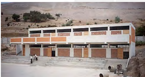
(e) Edificio escolar 780 - Pre (PCA)
