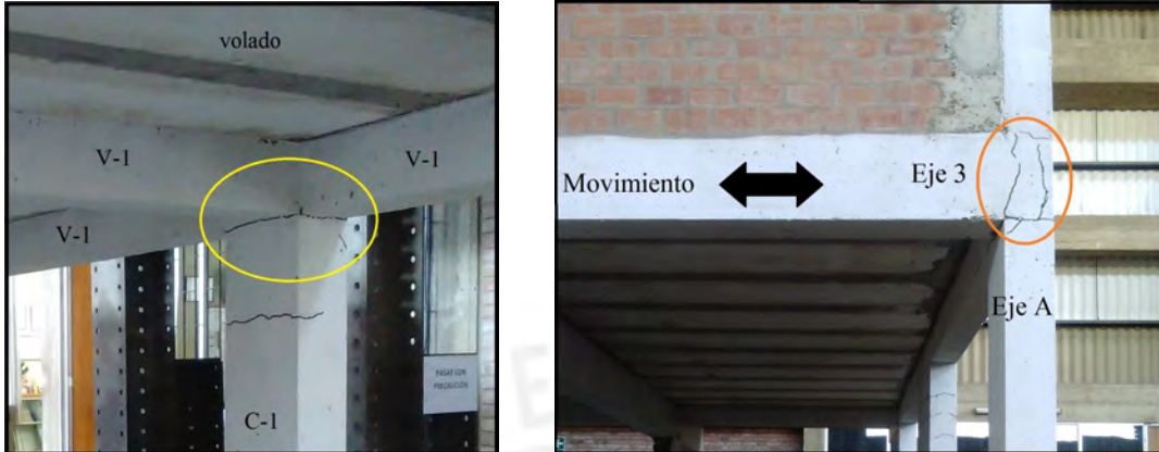
(a) Fisuras en la unión entre la columna C - 1 y las vigas del primer piso
