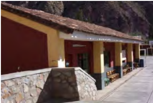
(a) Edificio escolar de adobe(A)
