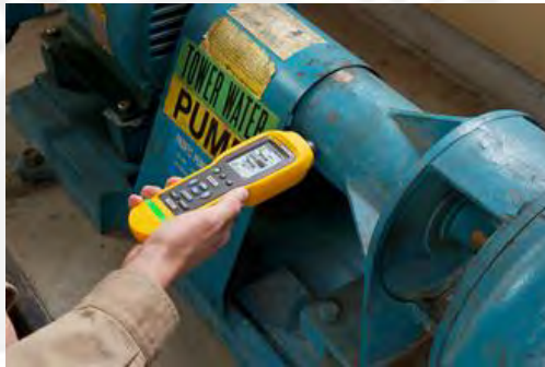
Figura 2.3: FLUKE 805 tomando muestras de una maquina en funcionamiento
