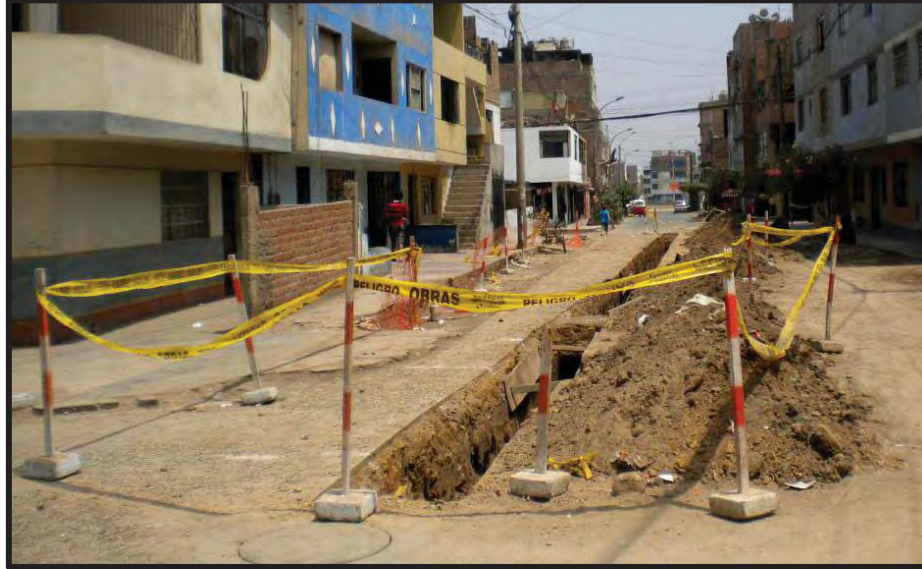
Figura 42: Obras para cambiar las tuberías en A1. Fuente propia
