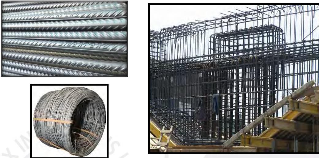
*Figura 6.* Barras de construcción y alambión, y su aplicación en obra.
