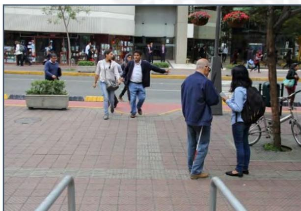
En la siguiente imagen se observa que las líneas podo-táctiles conducen hacia una zona que no es un cruce peatonal. Además hay una ciclovia, la cual tampoco está identificada adecuadamente. Adicionalmente al otro lado de la calzada no hay una rampa.
