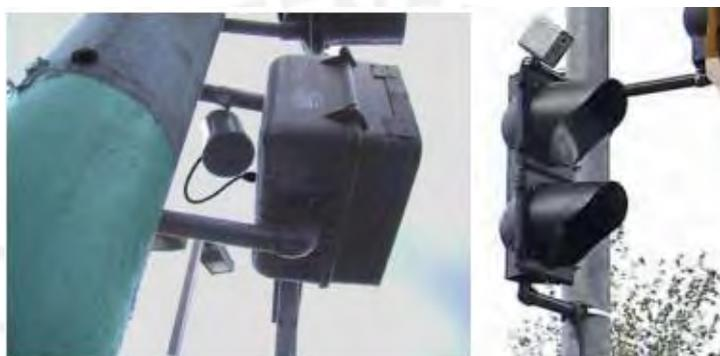
**Figura 2.8** Señal accesible instalada en la cabecera del semáforo peatonal (Pedhead-mounted APS)
