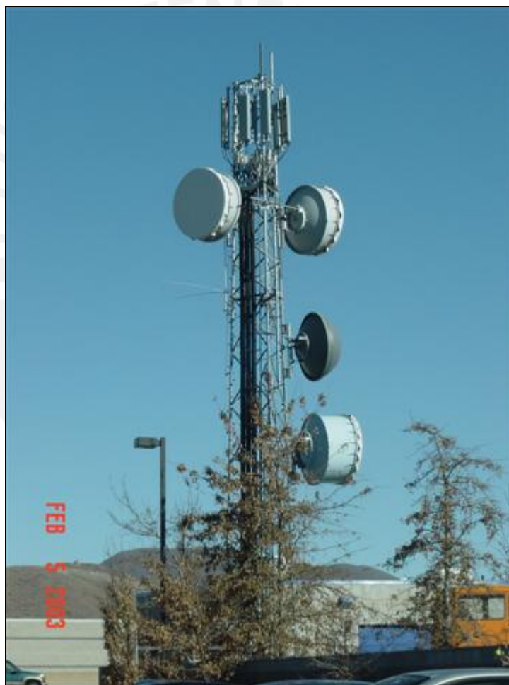
Figura 3.3 Antena para microondas Fuente: GUERRERO (2009)
