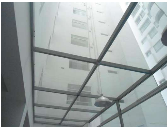
Imagen N° 16: Fotografía en la que se puede apreciar el techo colocado en el área de usos múltiples.
