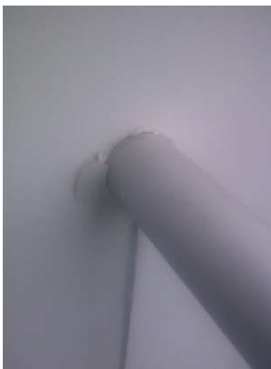
Imagen N° 6: Lado izquierdo de la baranda del balcón.
