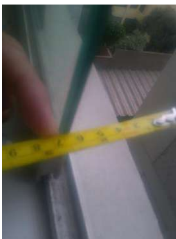
Imágenes N° 9 y 10: Se puede apreciar la medición efectuada a las ventanas y las aberturas que éstas presentaban.
