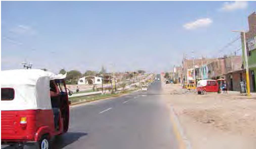
Avenida principal asfaltada, el resto de la zona aún no cuenta con pistas ni veredas
