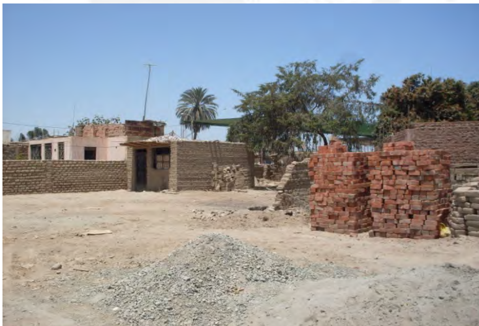
Predio afectado por el terremoto del 2007 con materiales para nueva construcción
