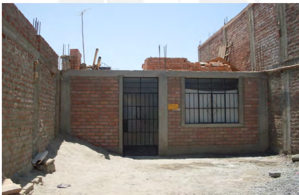
Modulo de vivienda del programa "Techo Propio" en el Pueblo Joven Hilda Salas
