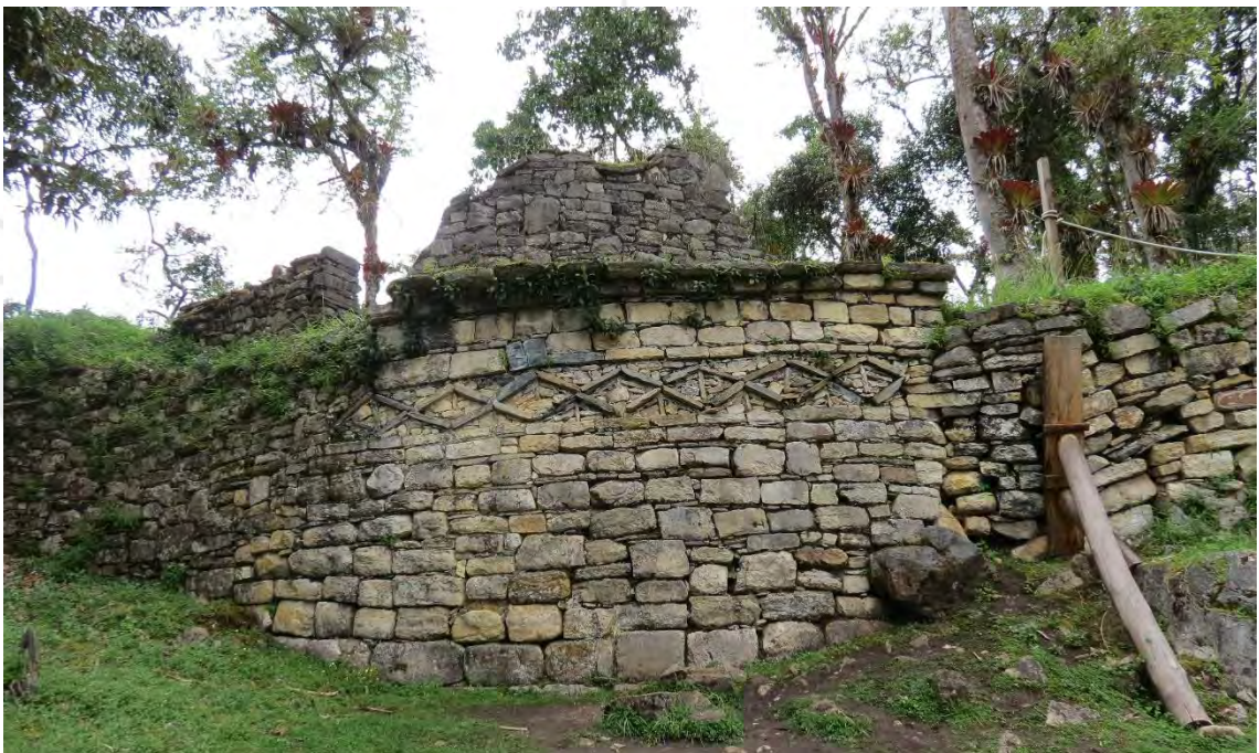
Figura 32. Fortaleza de Kuelap (Muro con adornos de piedra) Muro con adornos de piedra que simulan los ojos de un felino como parte de la ornamenta presente en las construcciones y arte Chachapoya
