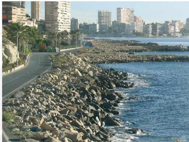
**Figura 3-15.** Dique en talud.
