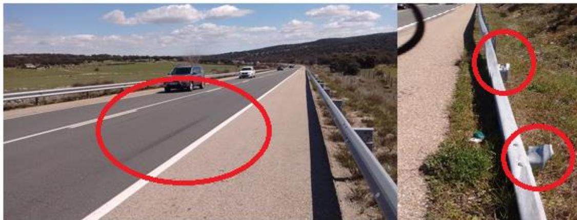
Figura 33. Huella de frenado en la plataforma y unos metros más adelante existen abolladuras en los apoyos de a barreras metálicas.
