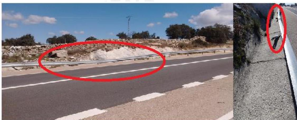
Figura 34. Barrera metálica desacoplada de sus apoyos posiblemente por un impacto con un vehículo.
