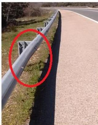
Figura 32. Abolladura de la barra metálica.
