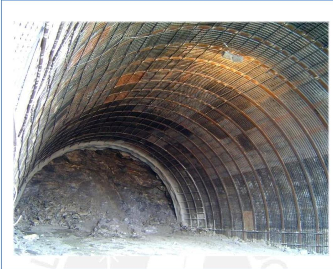
Figura 9 Costilla de acero HEB con planchas Bernold y hormigón.
