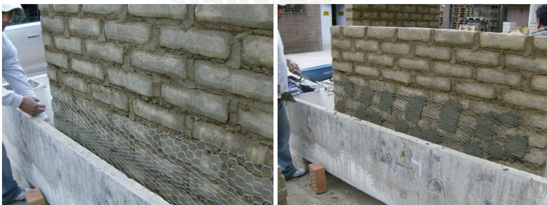
Foto 8.1. Colocación y fijación de la malla de alambre base para la aplicación de tarrajeo en el muro MT.
