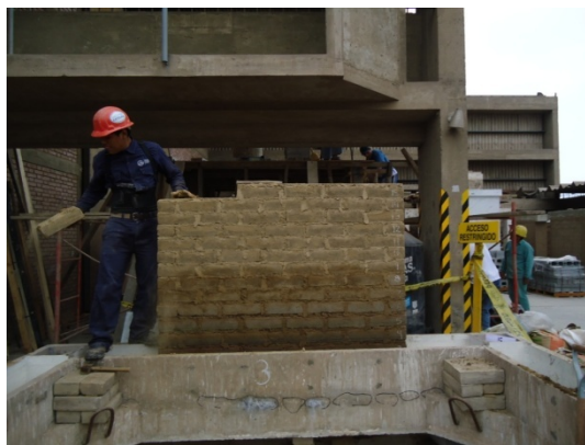
Foto 6.10. Fin del Ensayo de Inundación para el Muro Estabilizado ME, demolición manual.
