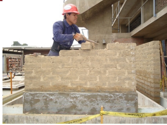
Foto 6.19. Fin del ensayo de Inundación para el Muro Tarrajeado MT, demolición manual.
