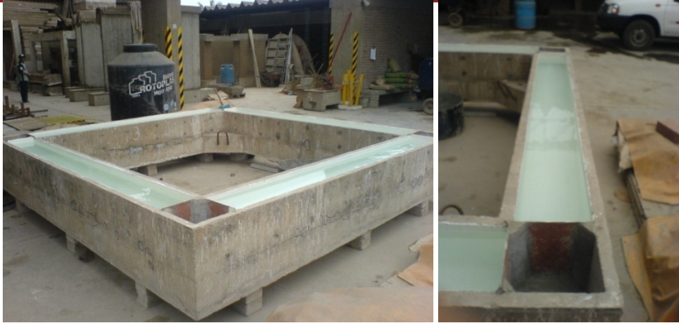
Foto 3.6. Prueba final de estanqueidad tras la aplicación del impermeabilizante Plasticoat.
