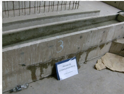
Foto 3.4 Primera prueba de estanqueidad.
