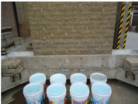
Foto 6.5. Preparación del ensayo de inundación en Muro Estabilizado ME, nótese las primeras 6 hiladas hechas de adobe estabilizado fácilmente reconocible por su color más claro.
