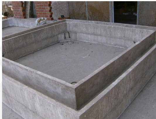
Foto 3.1. Canal U de concreto armado
