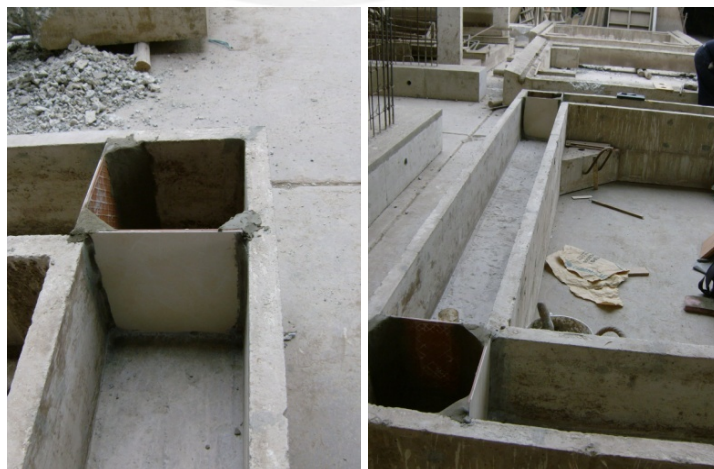
Foto 3.3. Detalle de segmentación del canal en U con piezas cerámicas.
