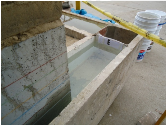
Foto 6.26. Ensayo de Inundación en Muro con Sobrecimiento MC.
