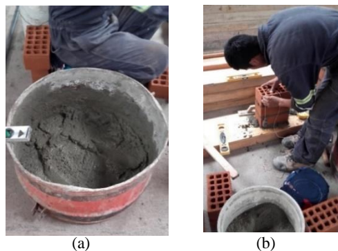
Figura 3.2. (a) Mezcla de mortero, (b) nivelado de ladrillos con plomada
