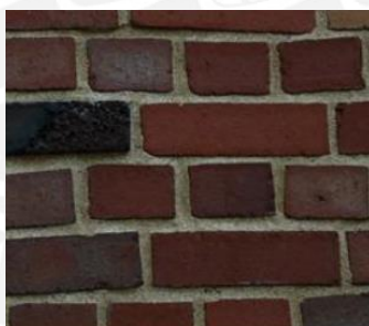
Figura 2.3. Mortero a base de cal (Godwa, 2014)
