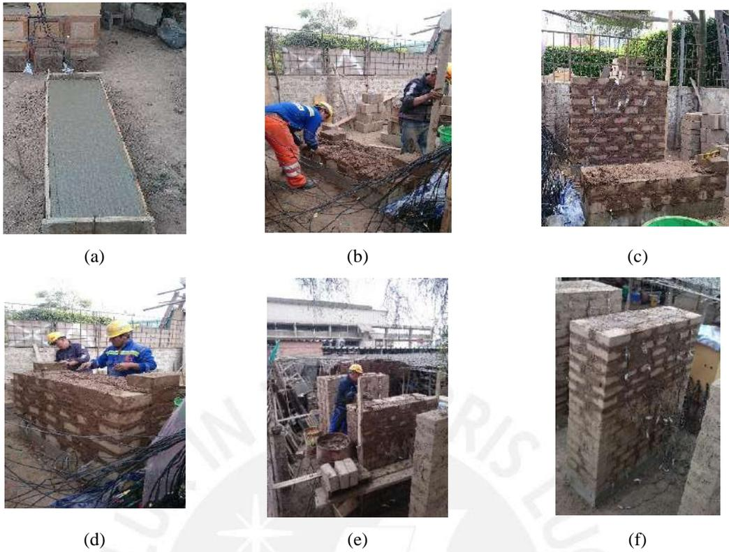
**Figura 5.9** Proceso constructivo muro tipo II (a) Sobrecimiento de concreto (b) Colocación de adobes en la base (c) Colocación de sensores (d) Muro a la mitad (e) Continuación del muro (f) Muro terminado.
