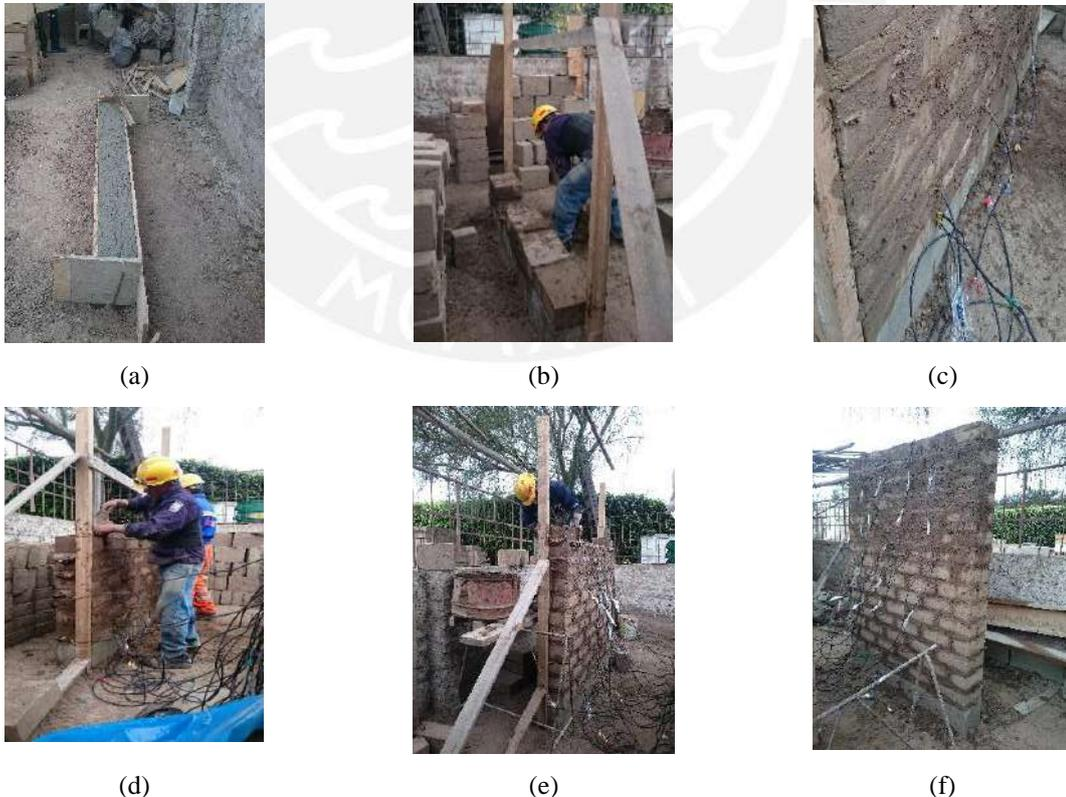
**Figura 5.8** Proceso constructivo muro tipo I (a) Sobrecimiento de concreto (b) Colocación de adobes en la base (c) Colocación de sensores (d) Muro a la mitad (e) Continuación del muro (f) Muro terminado.
