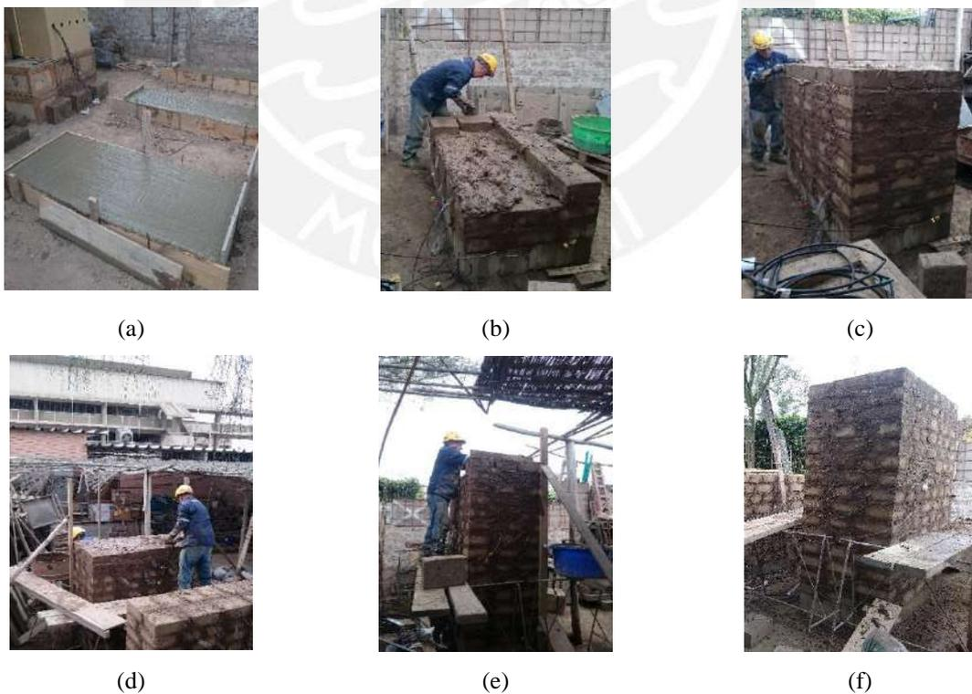
**Figura 5.10** Proceso constructivo muro tipo III (a) Sobrecimiento de concreto (b) Colocación de adobes en la base (c) Colocación de sensores (d) Muro a la mitad (e) Continuación del muro (f) Muro terminado.
