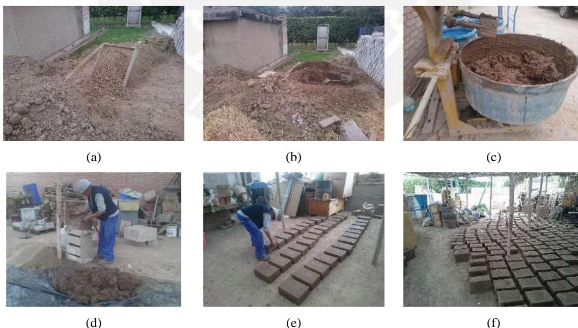
**Figura 5.3** Proceso constructivo de unidades de adobes (a) cernir la tierra (b) humedecer la tierra (c) mezclado mecánico (d) enrazado de adobes (e) colocación de adobes (f) apilado de adobes.
