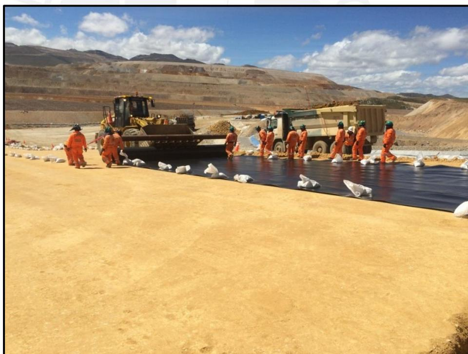
**Figura 26.** Despliegue de geomembrana (Elaboración propia)
