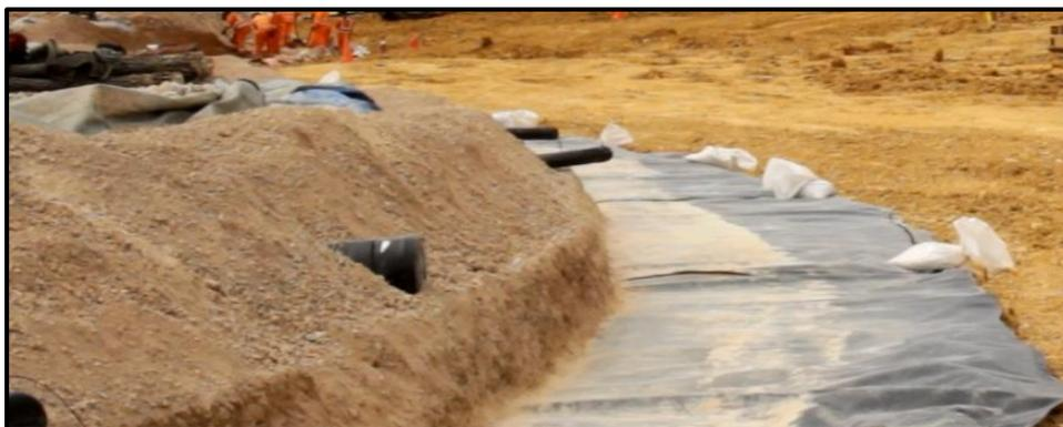
**Figura 27.** Geomembrana fase anterior y solapes (Elaboración propia)
