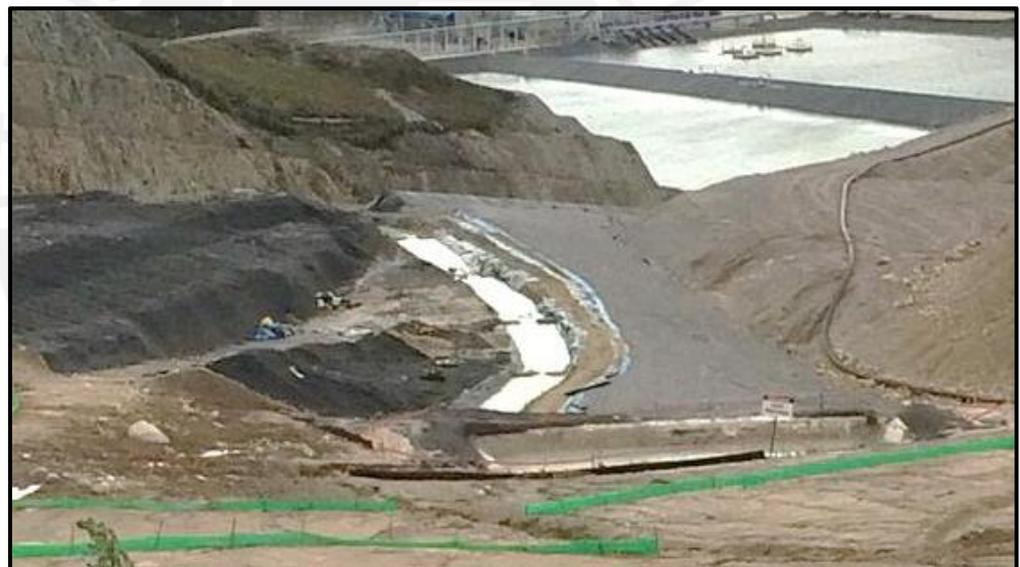
**Figura 11.** Disposición de check dams (Elaboración propia)
