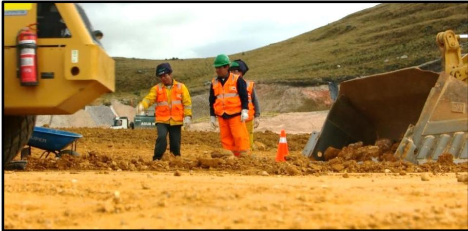
**Figura 19.** Disposición de material de baja permeabilidad (Elaboración propia)
