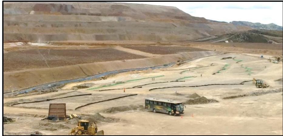
**Figura 10.** Disposición de silt fences (Elaboración propia)
