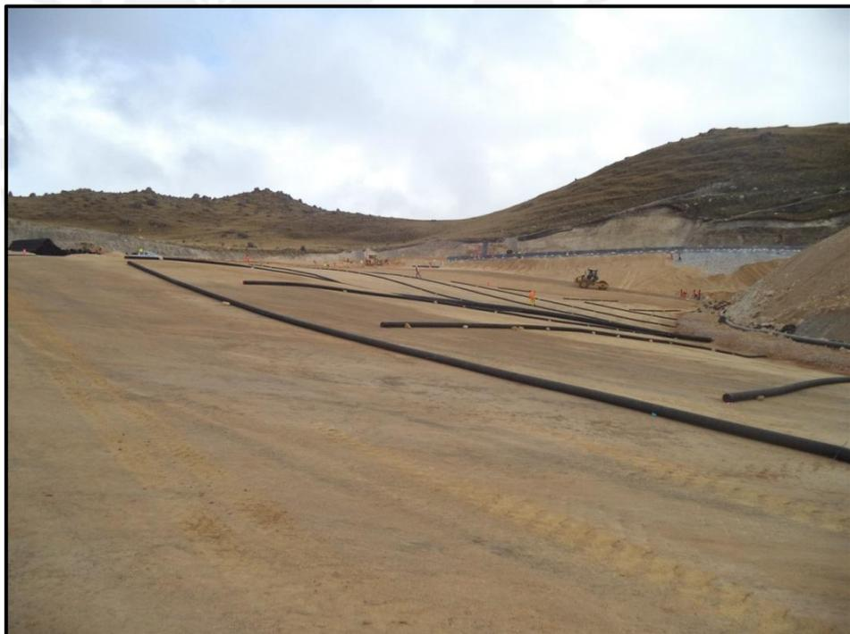
**Figura 29.** Colocación de tuberías de colección (Elaboración propia)
