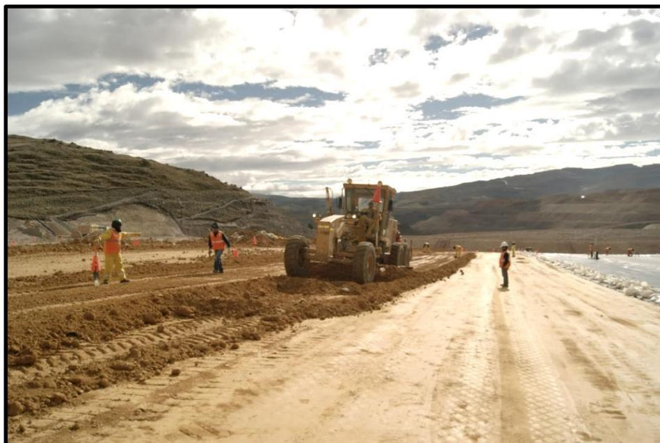
**Figura 24.** Liberación capa de relleno de baja permeabilidad (Elaboración propia)
