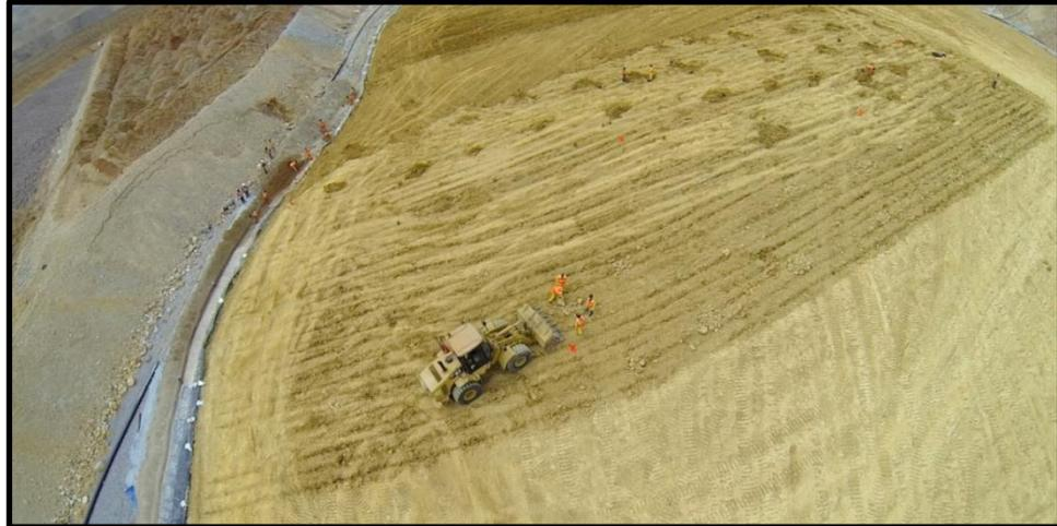
**Figura 18.** Disposición de material de baja permeabilidad (Elaboración propia)
