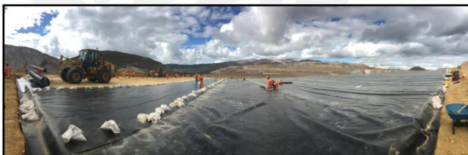
**Figura 25.** Colocación de geomembrana (Elaboración propia)
