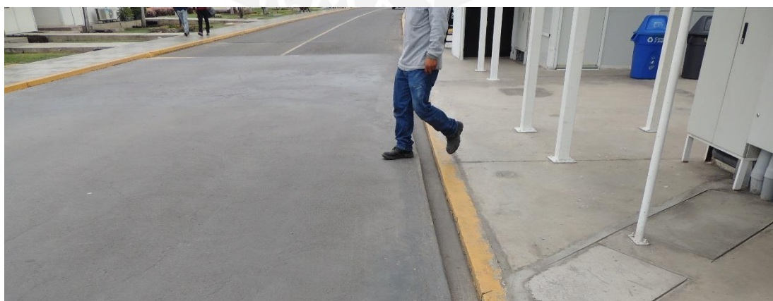
Figura 34. Zanjas a los costados en paso a nivel.
