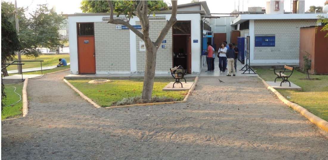
Figura 37. Acceso a CEMDUC y gimnasio no asfaltado.
