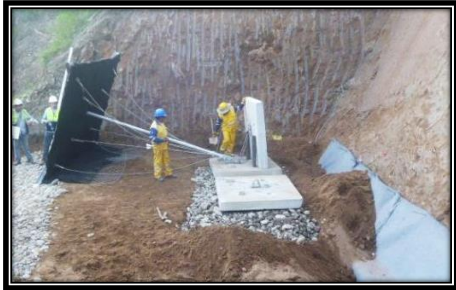
Figura N° 09 – Excavación de Terreno (Fuente: Betonform LA)
