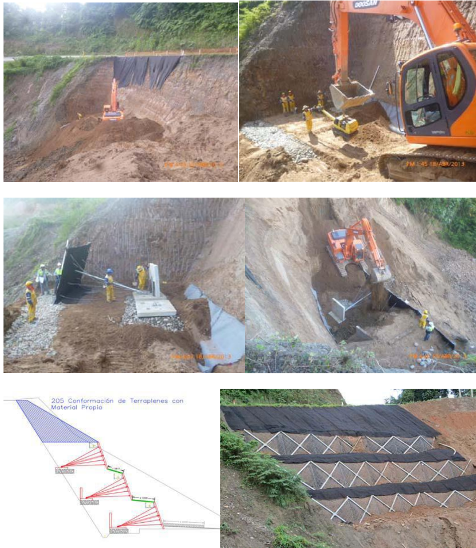
Figura N° 18 – Secuencia Sistema ErdoX IIRSA Sur (Fuente: Odebrecht)
