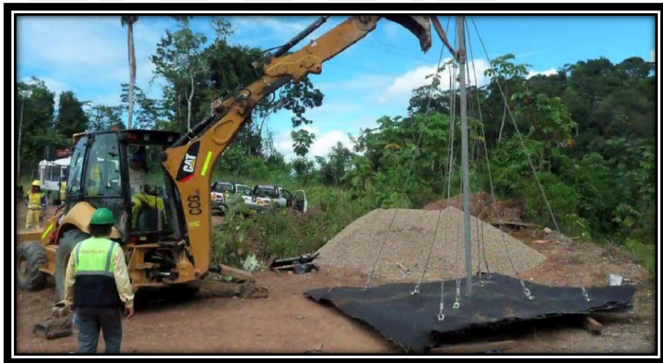
Figura N° 08 – Armado de elementos ErdoX (Fuente: Betonform LA)
