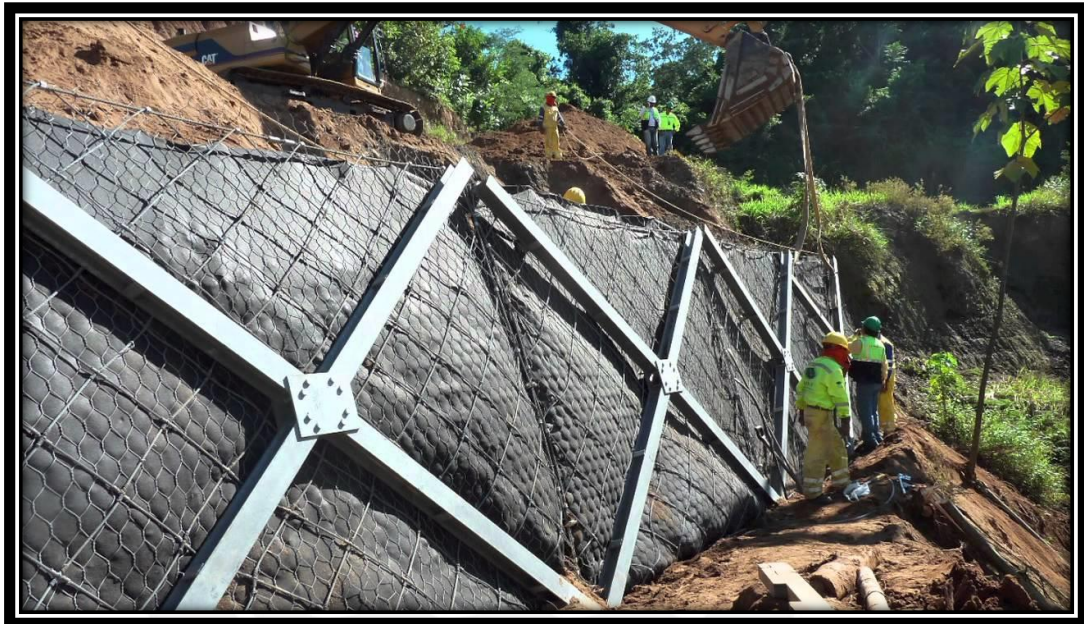
Figura Nº 10 - Imagen del Sistema ErdoX en construcción (Fuente: Betonform LA)
