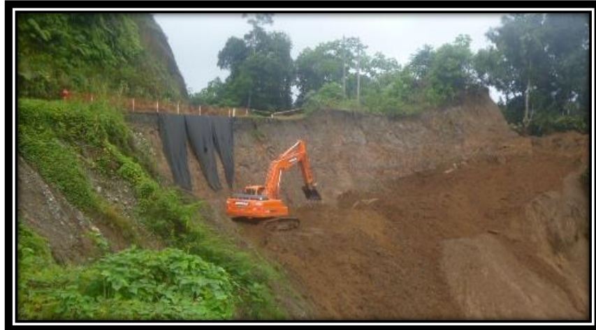
Figura N° 07 – Excavación de Terreno (Fuente: Betonform LA)
