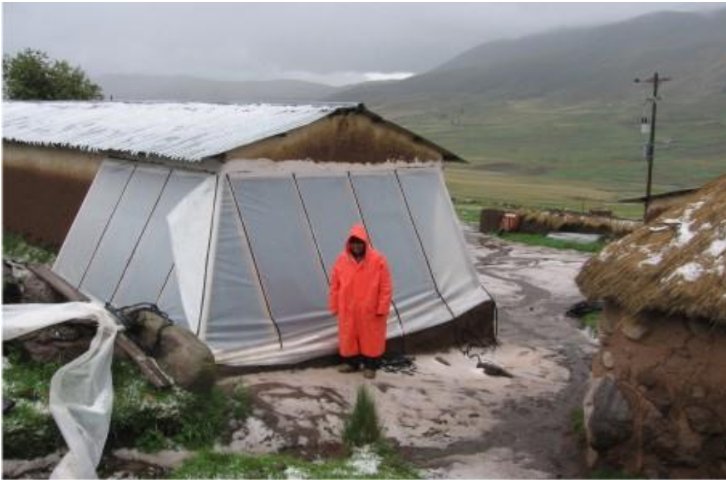
Figura N°2: Muro Trombe instalado en Langui en el proyecto realizado por el GRUPO-PUCP conjuntamente con la Cruz Roja. [7]
