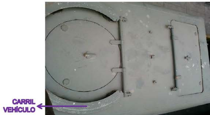
Figura A.5.2-1 Parte superior del tanque.
