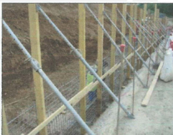
Figura 4-10 Instalación de Paneles GeoTrel
