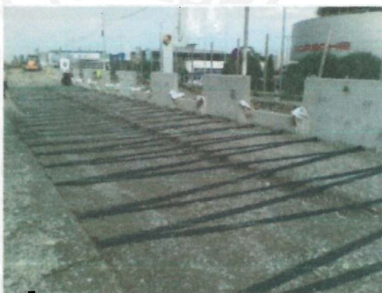
Figura 2-3 Cintas poliméricas instaladas Fuente: Tierra Armada Internacional
