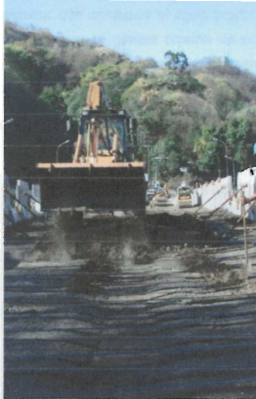
Figura 2-11 Instalación de Relleno Estructural
