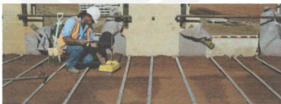
Figura 2-4 Flejes Metálicos Instalados Fuente: Tierra Armada Internacional
