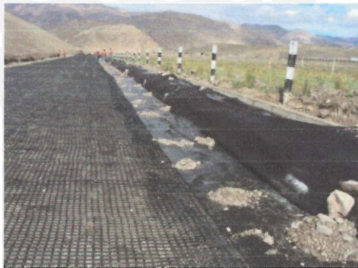
Figura 2-6 Geomallas Uniaxiales tendidas.
