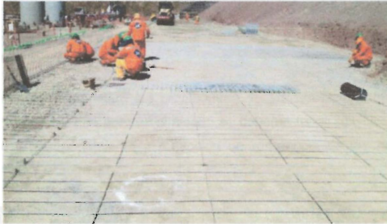
Figura 2-5 Mallas de Acero Instaladas
