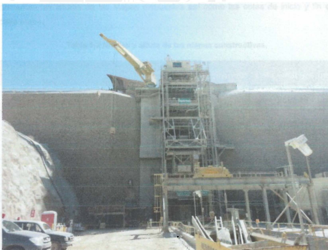
Figura 1-1 Muro de Suelo Reforzado en chancadoras Fuente: Tierra Armada Internacional
