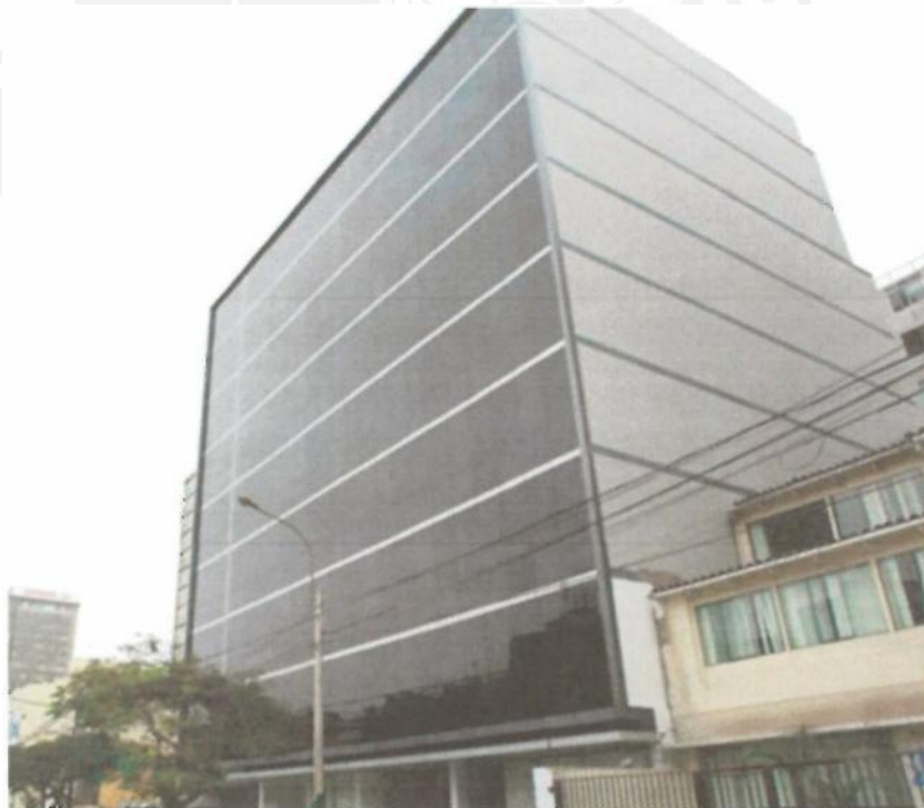
Imagen N° 1: Vista del Proyecto
