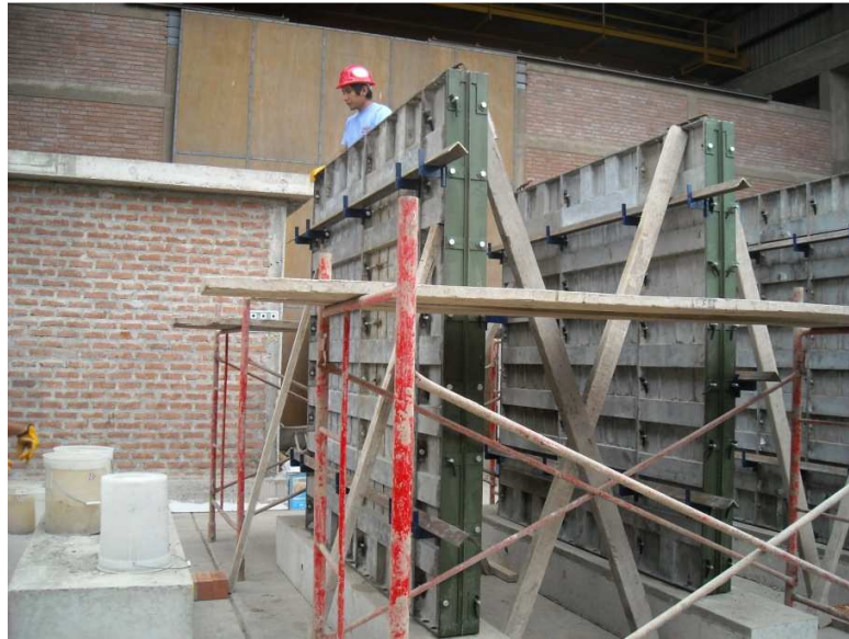
Foto 3.3: Muros Encofrados.
