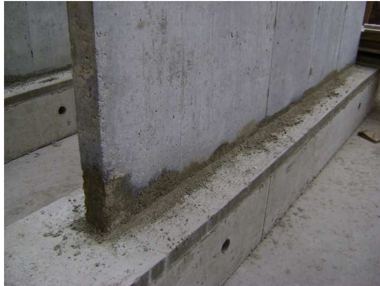
Foto 3.9: Reparación de las cangrejas.
