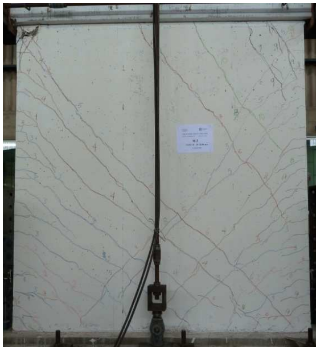
Foto 4.8: Estado Final del muro M-2, Deriva=0.8%
