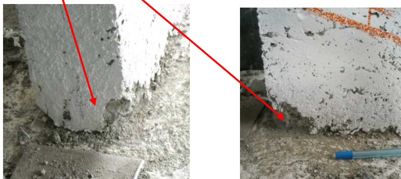
Figura 4.8: Fisuras en la Fase 10 Muro M-1
