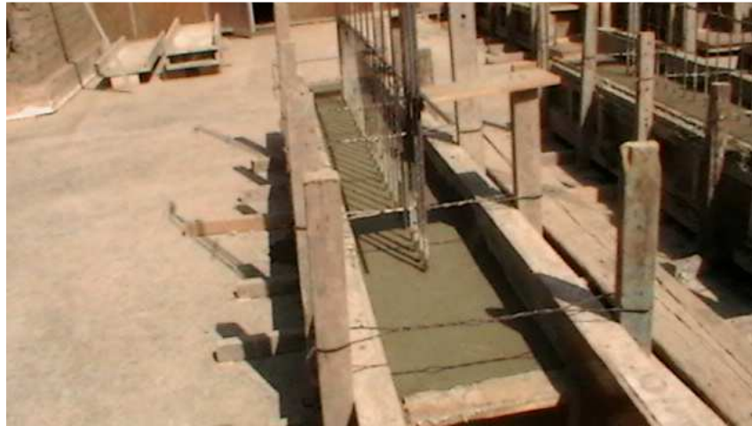
Foto 3.2: Encofrado y Vaciado del Concreto. Viga de Cimentación
