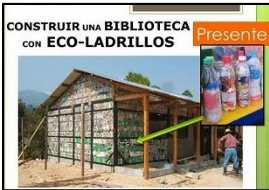
Ecobiblioteca en proceso de construcción
