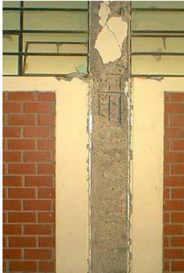
En estos años se inicia el detallado de la tabiquería en los planos de estructuras y se comienza a colocar columnetas y una viga collar superior ( solera ), con el objeto de tener al tabique o parapeto libre de la estructura principal, pero con arriostres para que pueda trabajar como un voladizo, en su plano perpendicular.
