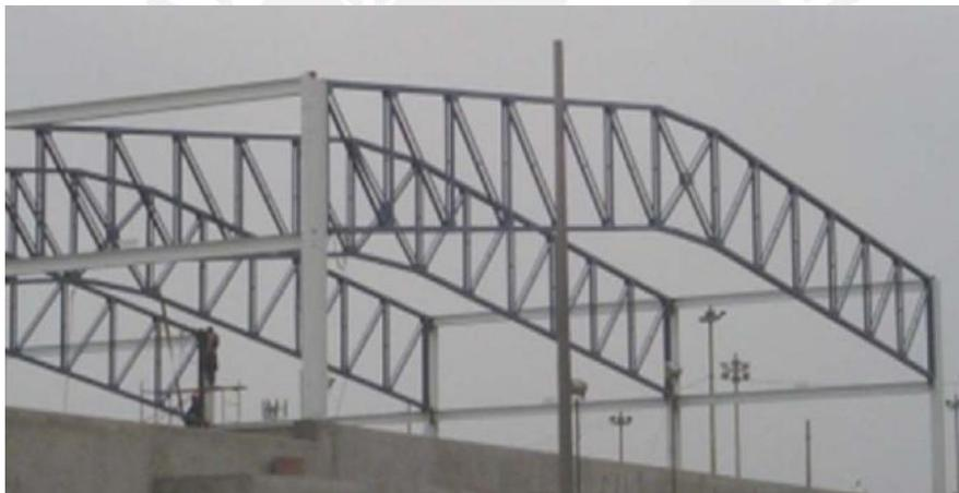
Entre ellas se dispusieron viguetas o correas con planchas metálicas ligeras, como se puede apreciar en la imagen.
