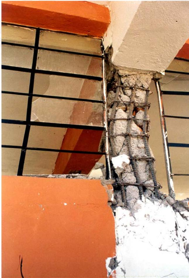
La mayoría de los centros educativos del Perú tiene dos pisos, con una estructura compuesta por dos pórticos en la dirección longitudinal (uno con ventanas altas y otro con ventanas bajas), mientras en la dirección transversal se tienen muros de albañilería confinada (que son las divisiones entre aulas) y pórticos con vigas peraltadas ubicados hacia el centro de las aulas. Tienen además un corredor que sale en volado de los pórticos y de los muros de la dirección transversal.
