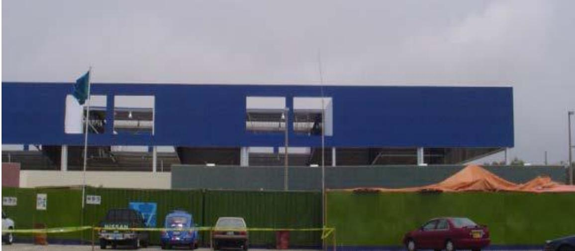
En las fachada lateral, se tenía una última armadura reticulada, igual a todas las interiores. Sin embargo, desde esta última salen en volado otras armaduras transversales que tienen como función el soportar un cerramiento vertical de altura constante, que luego se recubre con planchas ligeras tipo Drywal
