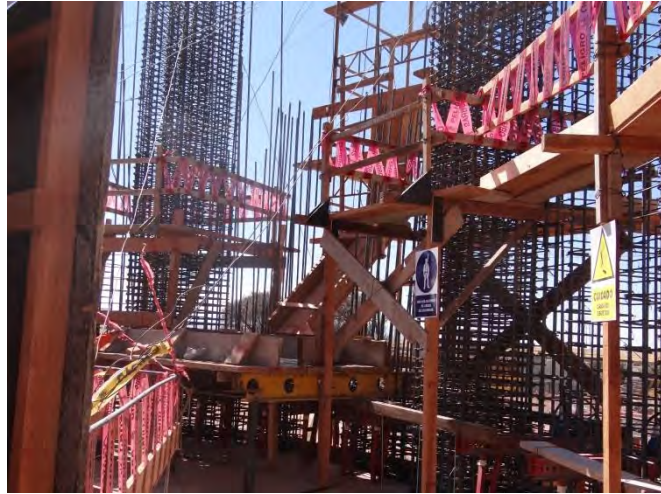
Figura 3.11.- Finalización de armado de entramados (3)
