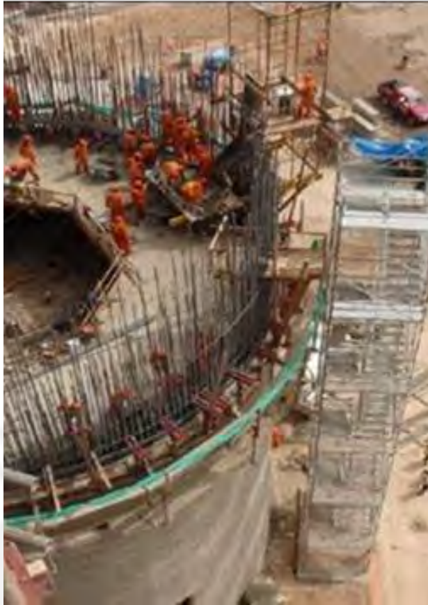
Figura 3.17.- Escalera de acceso (3)
