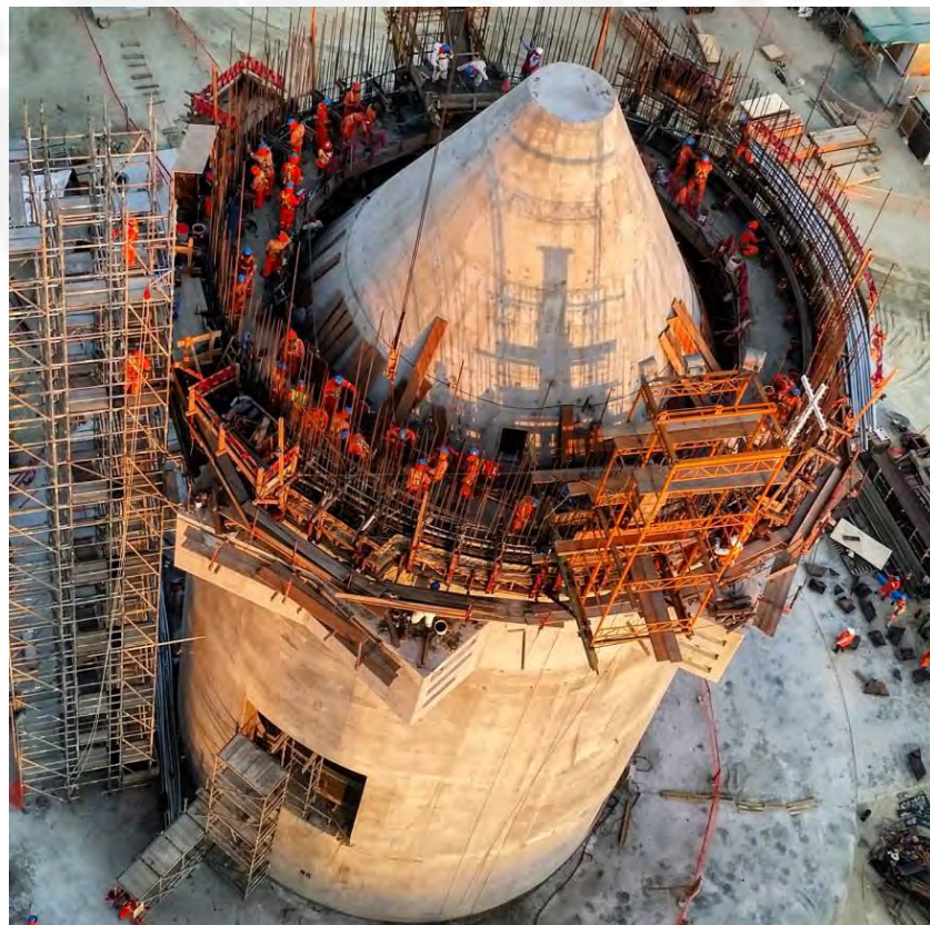
Figura 5.2.- Sistema de encofrados deslizantes (3)
