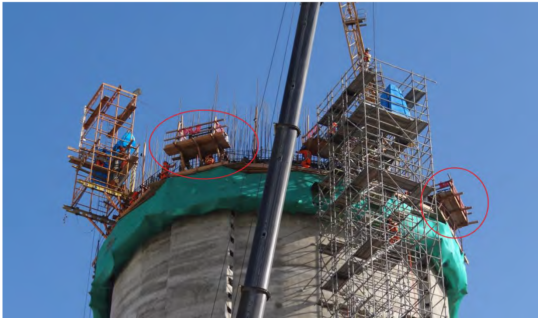
Figura 3.16.- Plataformas en volado para recepción de materiales (3)
