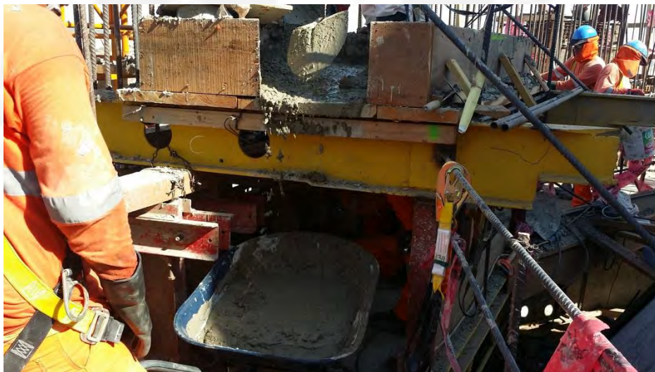
Figura 4.3.- Llenado de boggies desde plataforma (3)
