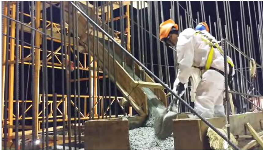
Figura 4.2.- Momento en que se vacía del balde a la plataforma (3)
