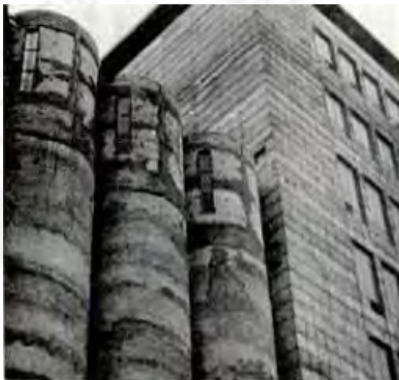
Figura 1.1.- Acabados de silos ejecutados con gatos mecánicos. (6)
