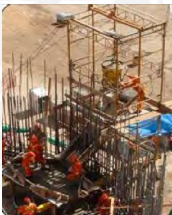
Figura 4.4.- Sistema de izaje de concreto (3)
