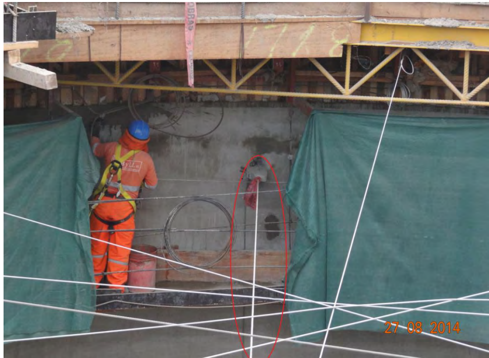
Figura 2.4.- Templador para corrección de verticalidad (3)
