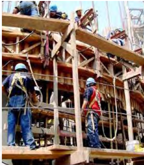
Figura 3.10.- Andamio inferior exterior (3)
