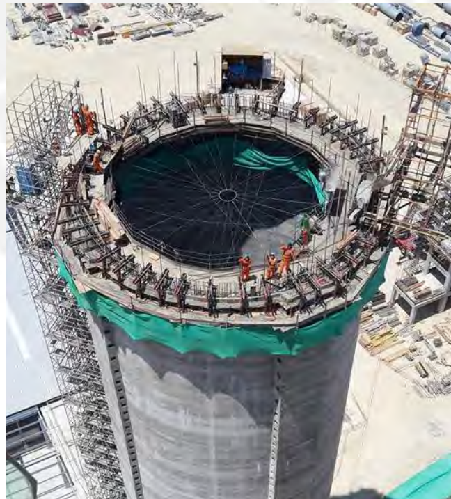
Figura 2.6.- Templadores radiales trabajando en conjunto (3)
