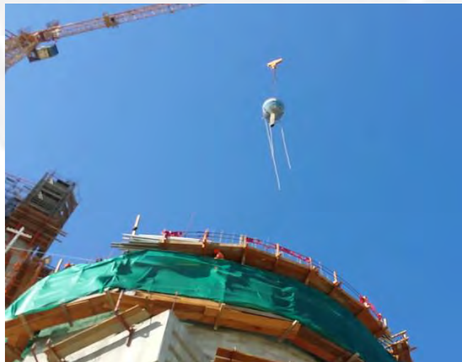
Figura 9.2.- Izaje del balde con la grúa (3)
