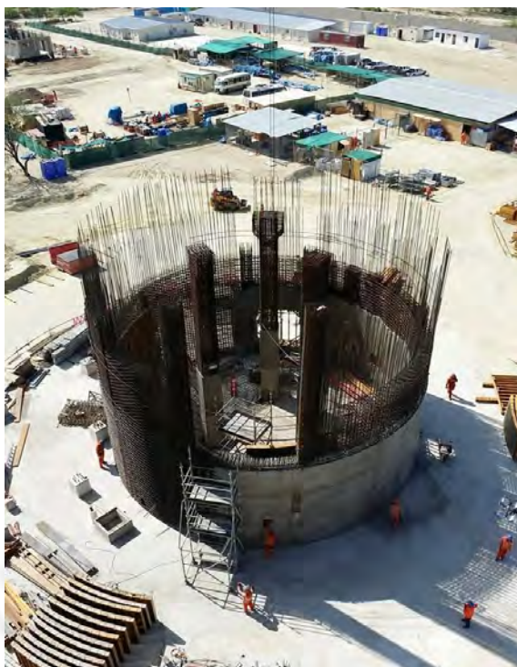
Figura 3. 3.- Vista exterior del mismo silo (3)
