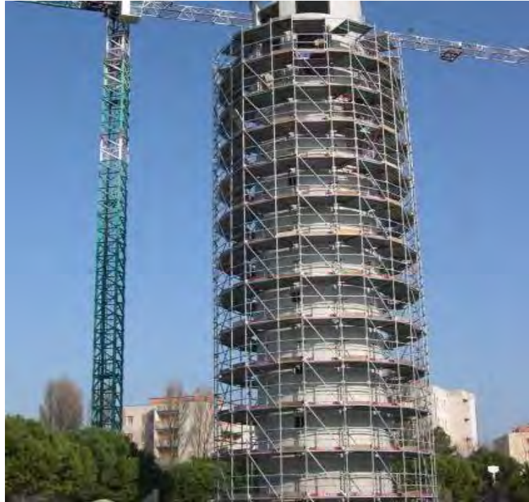
Figura 5.1.- Sistema convencional de encofrados (5)
