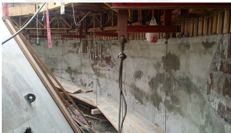
Figura 3. 9.- Armado de andamio inferior interior (3)
