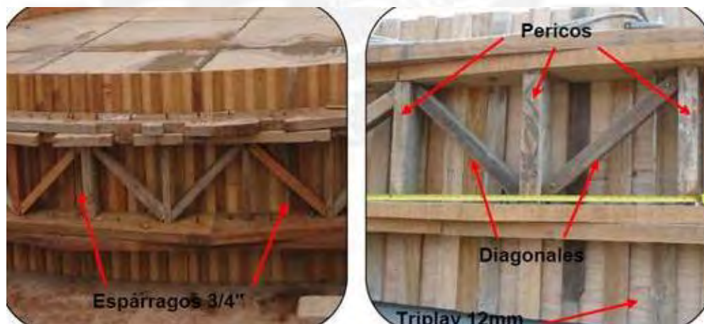
Figura 3. 4.- Elementos del encofrado (4)
