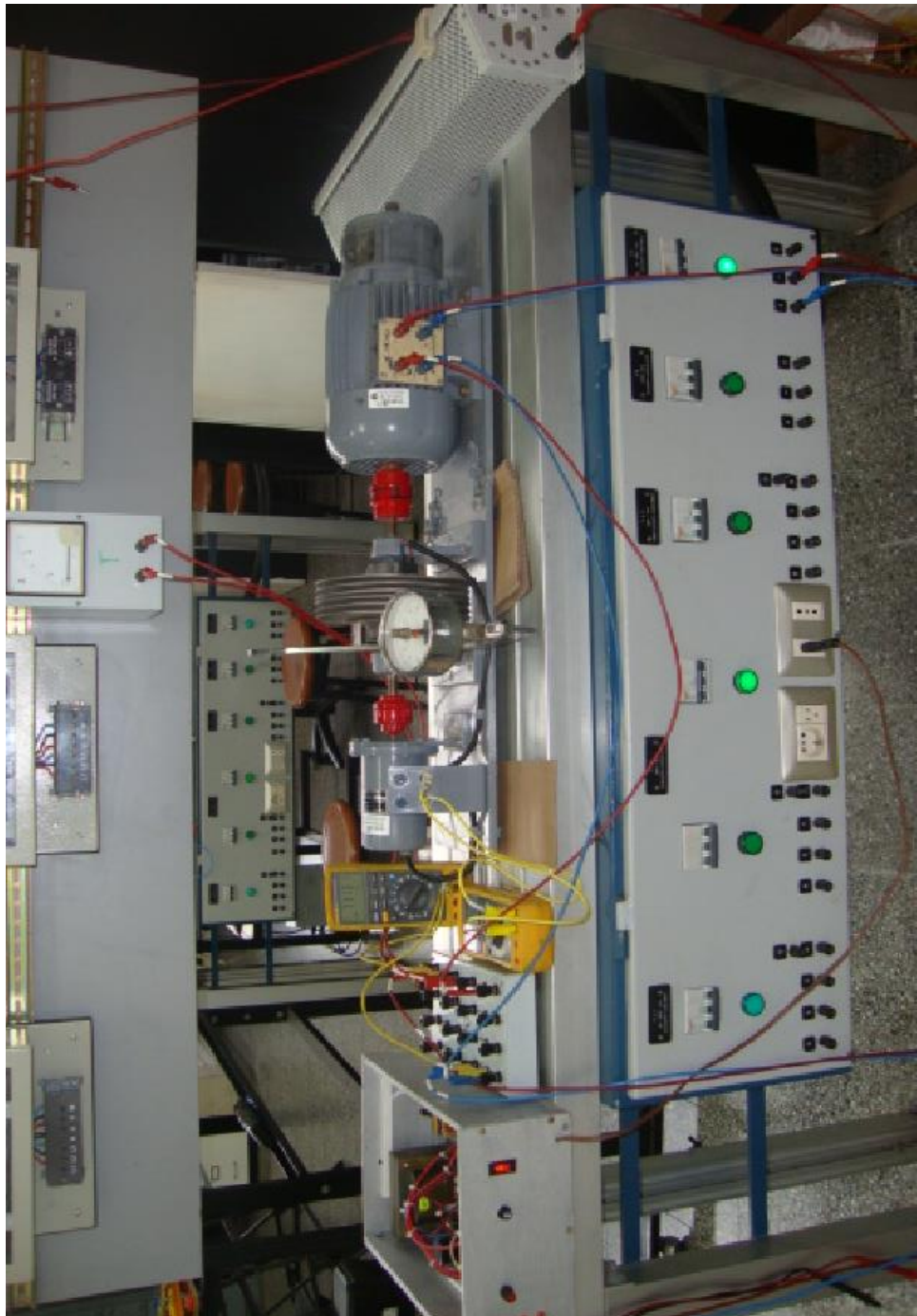
Figura 4.5 Armado de prueba con el motor DC (Fuente: Propia).
