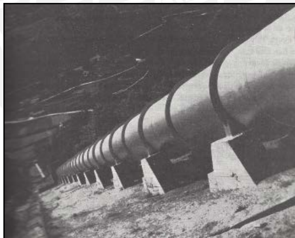
Figura 10. Tubería forzada del Salto de Las Conchas, España (Zoppetti, 1979).
