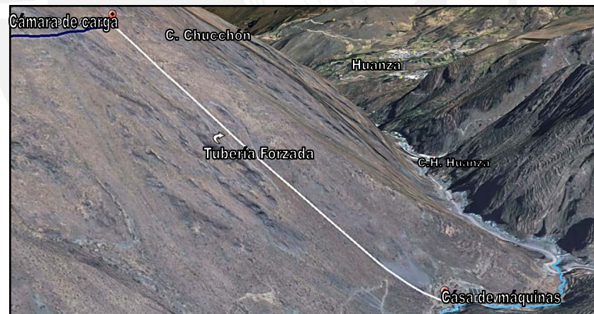
Figura 21. Ubicación de la tubería forzada y de la casa de máquinas (Elaboración Propia).
