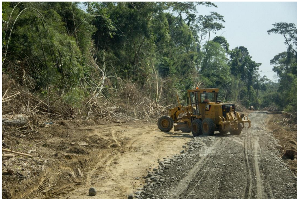
Figura 13: En la fotografía se observa que el espacio adicional al ancho de vía es utilizado como espacio para la maniobra de la niveladora. Fotografía propia.
