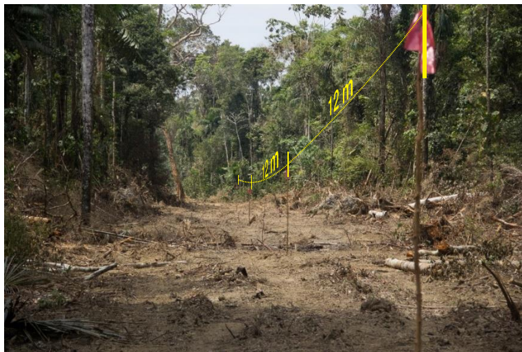
Figura 11: Fotografía de la zona de trabajo días después del desbroce. Se pueden apreciar las varillas distanciadas a 12 m que sirven de guía para la ubicación de la vía. Fotografía propia.
