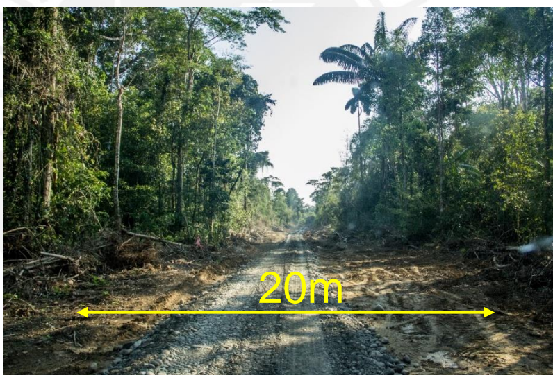
Figura 12: La fotografía permite apreciar el ancho de 20 m deforestados para la construcción de la carretera. Fotografía propia.
