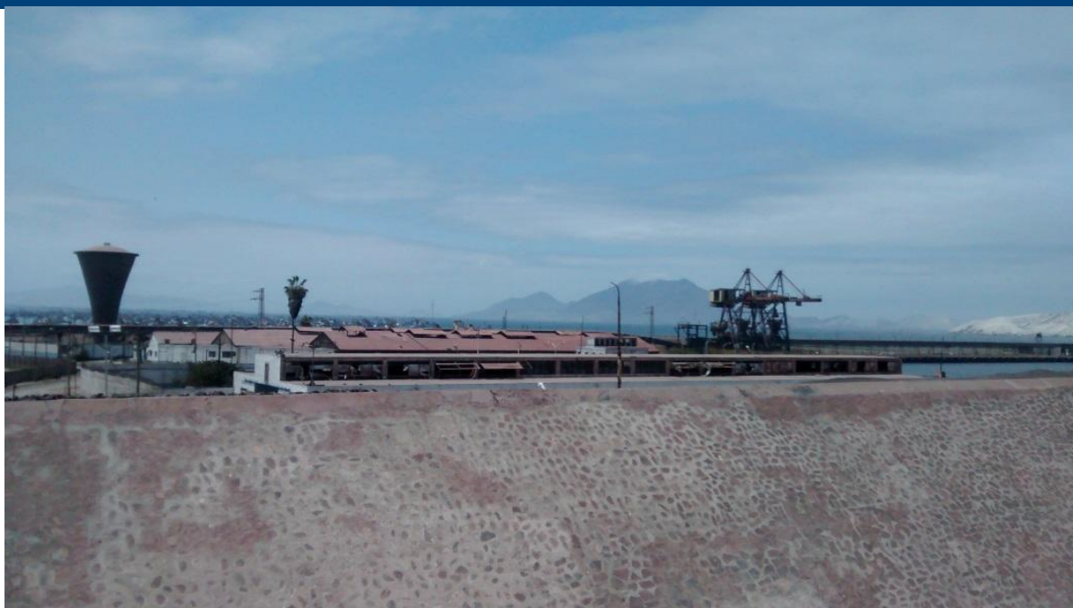
Figura 70. Terminal Portuario de SIDERPERU
