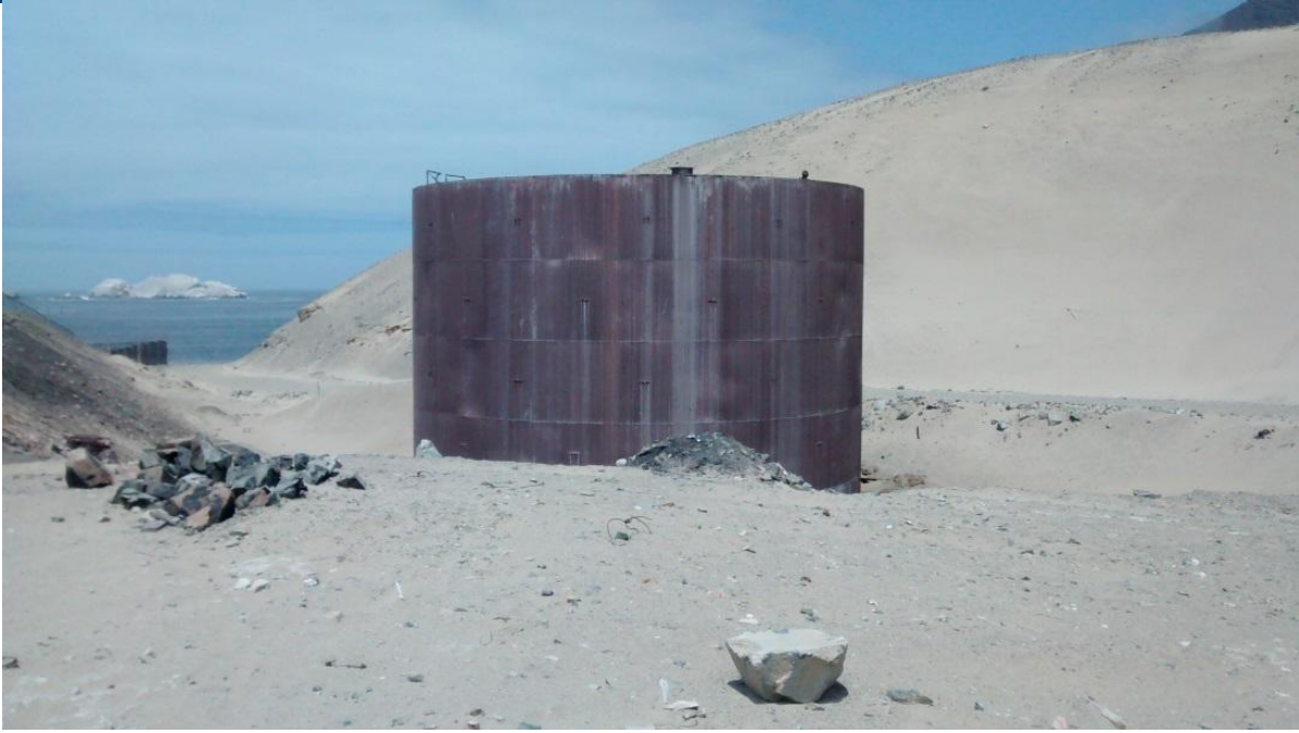
Figura 72. Tanque de Almacenamiento de combustibles sin utilizar.
