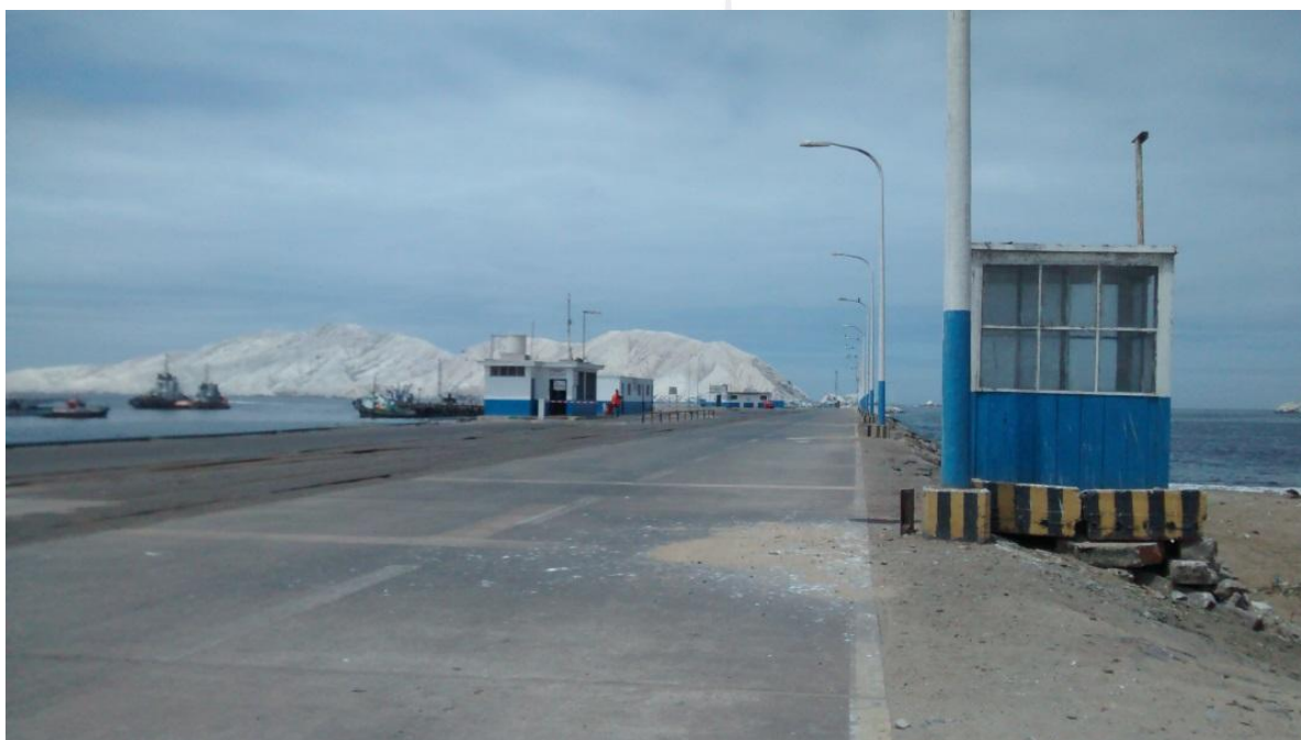
Figura 65. Ingreso a plataforma del muelle 1.
