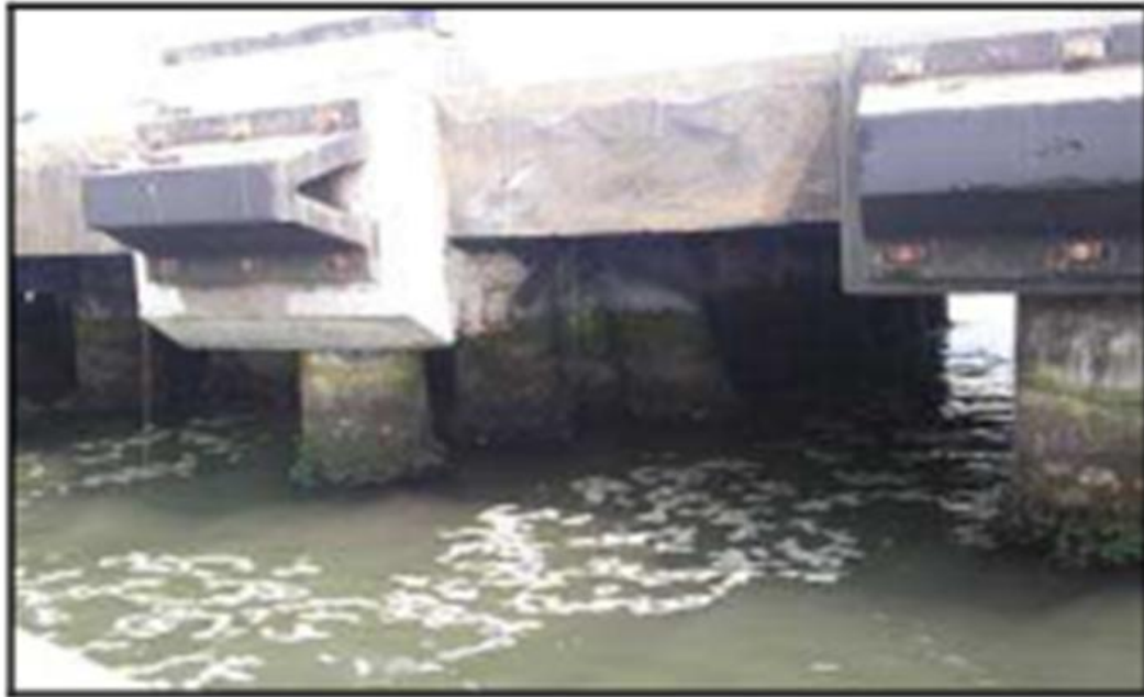
Figura 43. Pilotes y defensas del muelle 1
