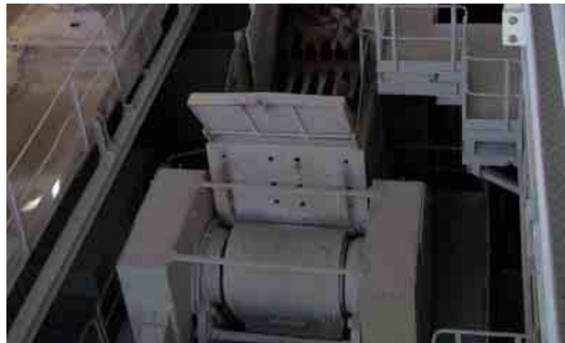
Una C200 tras la sustitución de una trituradora de mandíbulas de doble placa basculadora. Se ha aumentado la capacidad de la planta sin necesidad de modificar la cimentación.
