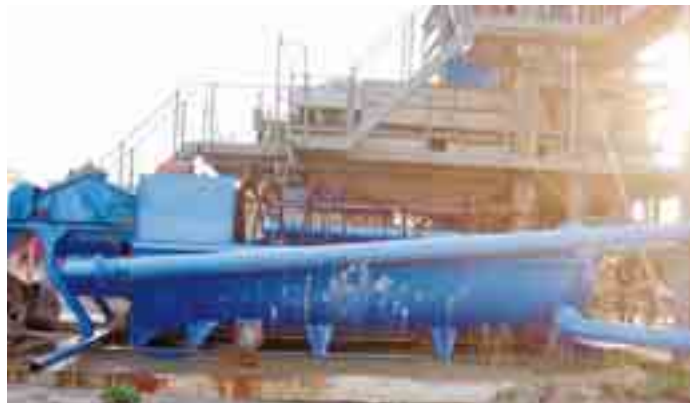
Separador de arena en operación
