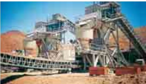
1. Tres trituradoras GP500 operando en una cantera de 4,2 millones de toneladas al año, produciendo agregados de alta calidad en Noruega.
