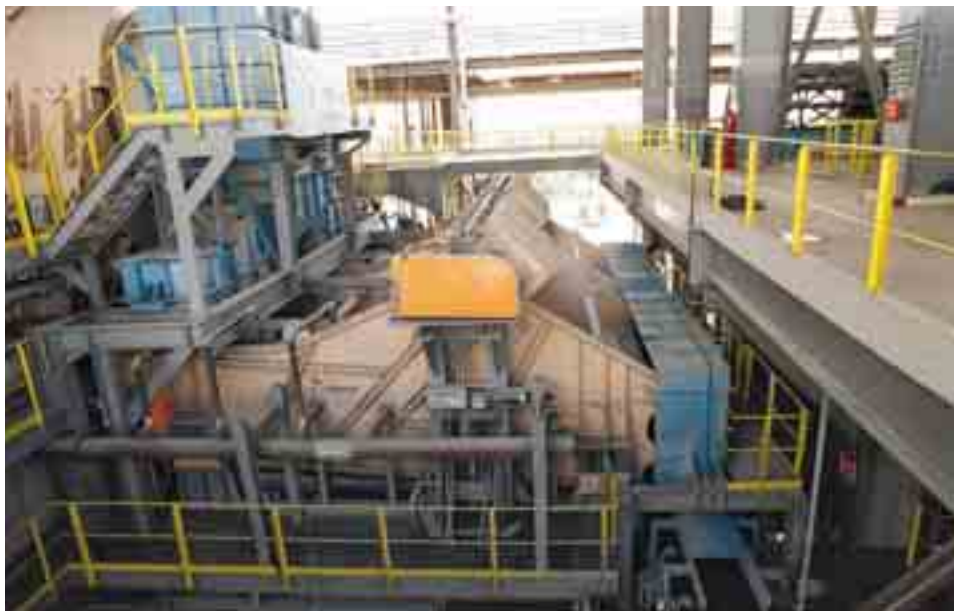
Cribas Low Head DD 12" x 24", con tres mecanismos de caja en la descarga de un molino SAG.
