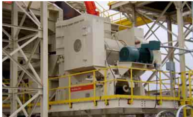
Una C145 durante la fase de instalación en una nueva planta de trituración primaria.
