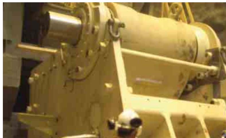
Una trituradora de mandíbulas A Nordberg C200 en el proceso de montaje en una mina subterránea. La trituradora fue transportada en piezas y ensamblada bajo tierra.
