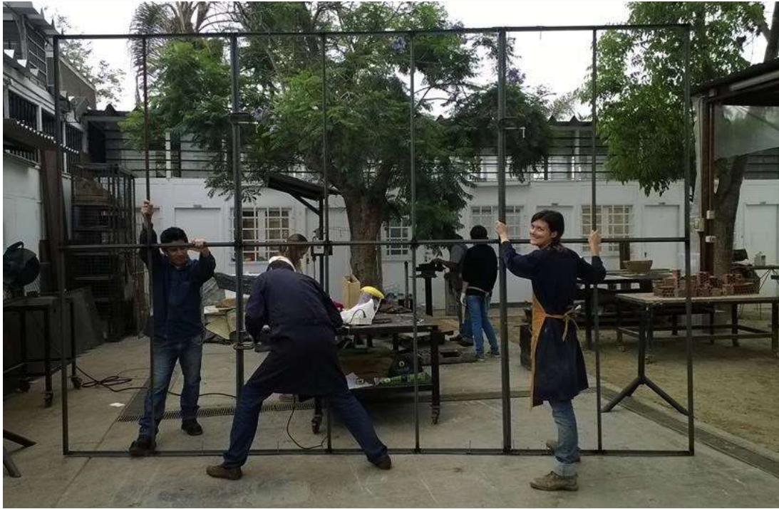
Construcción de la estructura en metal.
