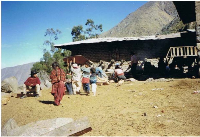
Fotografía 20. Construyendo la casa: primera etapa
