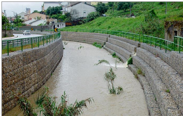
Figura 15. Defensa ribereña con muros de gavión (Fuente: Maccaferri)
