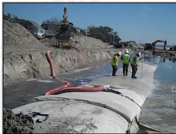
Figura 7. Llenado con tolva y tubería corrugada flexible
