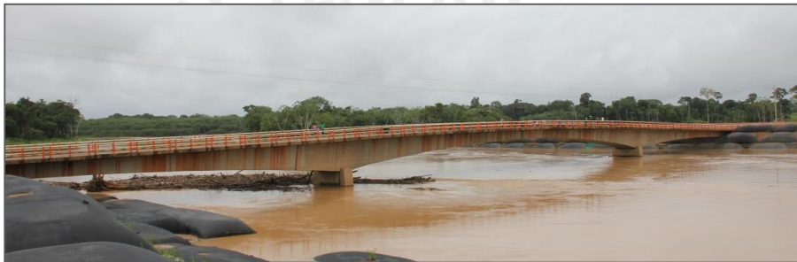
Figura 9. Puente Tahuamanu (Fuente: Propia)
