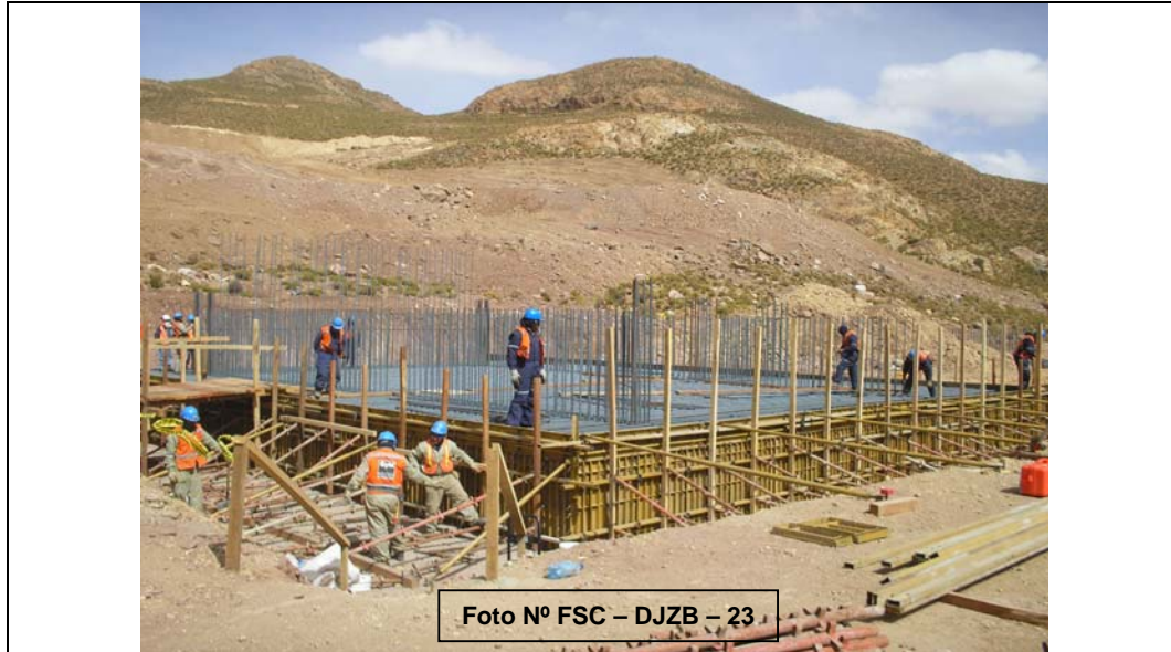
CONSTRUCCION DEL NIVEL DE FUNDACIÓN
