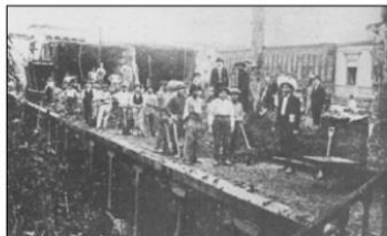
⑥ INCENDIO DEL 3 DE JULIO DE 1921, OBREROS DEMOLIENDO ESCOMBROS, CALLE PALACIO. EN: FUENTE DESCONOCIDA.
