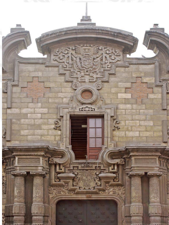
Fig. 72 Detalle del escudo nacional del Pabellón Perú en Sevilla, 1929.
