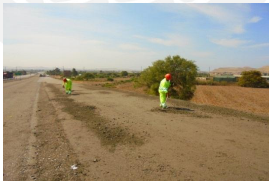
Figura 097. Etapa 9: Resanes con material suelto de Base granular en ambos carriles. Fuente: Propia.
