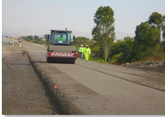
Figura 075. Etapa 7: Compactación de la plataforma para obtener la compactación al 100%. Fuente: Propia.
