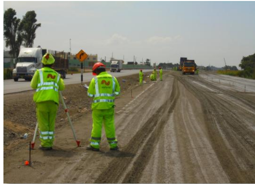
Figura 011. Etapa 1: Colocación de Puntos para el colocado de Base Granular. Fuente: Propia.
