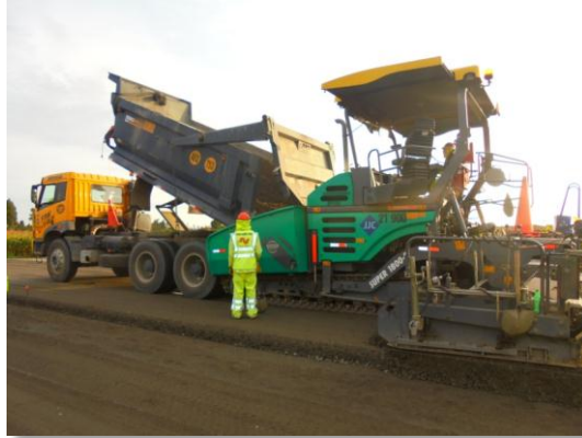
Figura 04. Etapa 4: Colocación de la capa de base granular con Esparcidora. Fuente: Propia.
