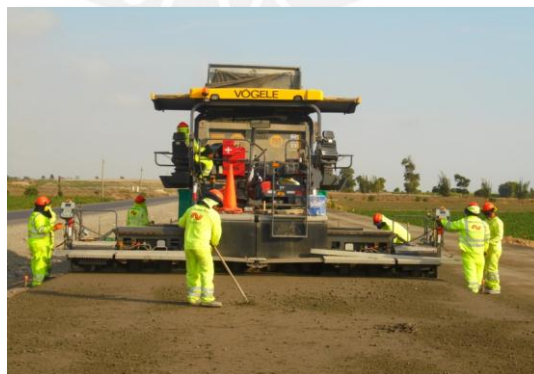
Figura 064. Etapa 6: Resanes con material suelto de Base granular para el acabado final de la plataforma. Fuente: Propia.
