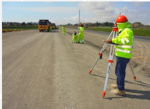
Figura 02. Etapa 2: Colocación de estacas para el nivel del espesor de Base. Fuente: Propia.
