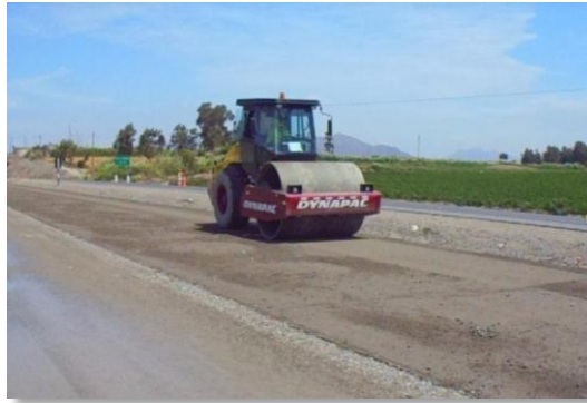
Figura 108. Etapa 10: Compactación del carril izquierdo para su liberación a Calidad y Supervisión. Fuente: Propia.
