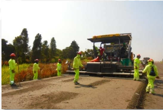
Figura 053. Etapa 5: Verificación de espesor de base granular con las reglas de aluminio. Fuente: Propia.
