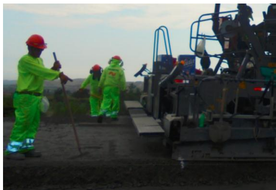
Figura 17. Rastrillado de base.
