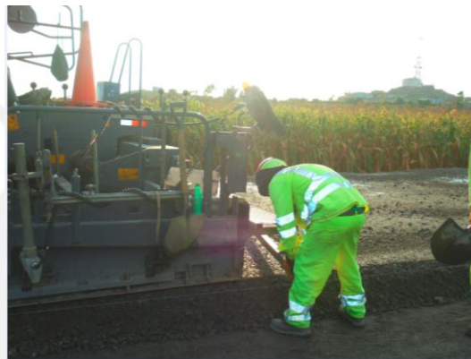
Figura 16. Asegurando el nivel correcto dejado por topografía.
