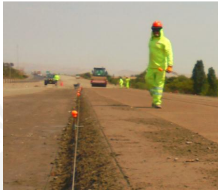
Figura 18. Colocación de balizas.
