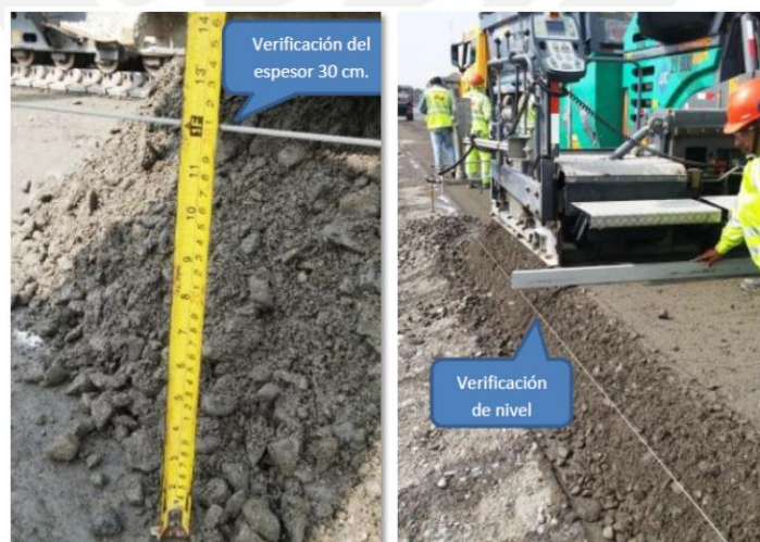
Figura 32. Aseguramiento del material base colocado.
