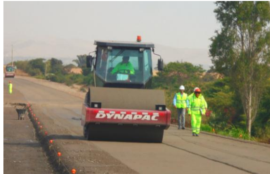
Figura 7. Rodillo liso vibratorio.
