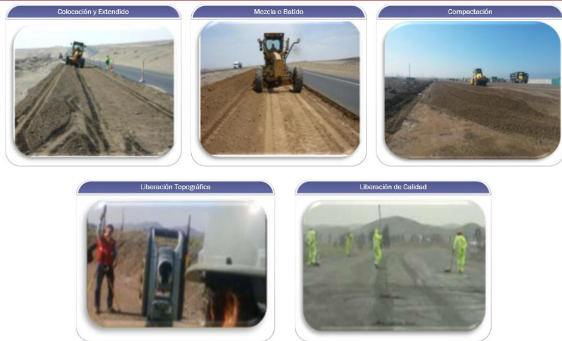
Figura 11. Esquema de colocación de base con Motoniveladora.
