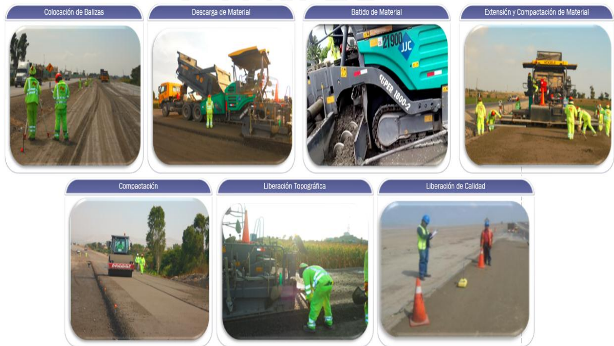
Figura 13. Esquema de colocación de base con Esparcidora.
