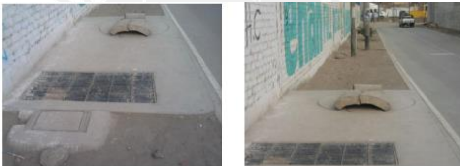
Fotografía 5: Pozo del AAHH Cerro Las Ánimas. Fuente: SEDAPAL.
