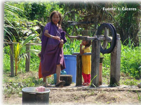
Ilustración 4: Único sistema de bombeo de agua en la CN Quempiri. A unos metros los usuarios realizan las acciones de aseo personal (ducha, lavado de ropa, lavado de utensilios, etc.) se ha observado desechos inorgánicos de sachets de shampú, jabones, pasta dental, el agua utilizada es absorbida por la tierra y probablemente alcancen al nivel donde se encuentran las aguas limpias. Los técnicos agropecuarios, que laboran en la zona, han encontrado indicios de que las aguas servidas están contaminando la fuente de agua limpia.
