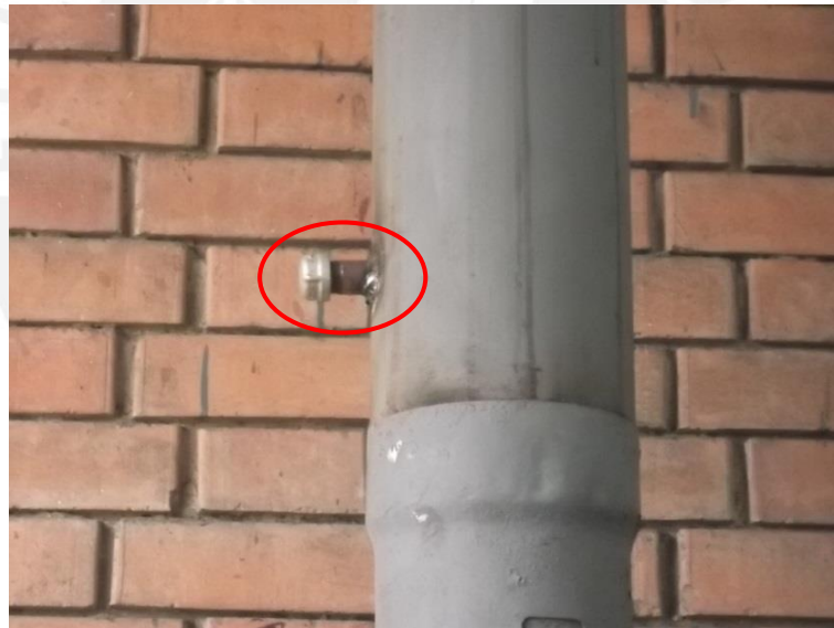
Figura 1.9. Arreglo en el ducto de escape de la fragua.
